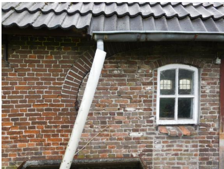
Figuur 16 - Detail achtergevel; ook hier is een oorspronkelijke getoogde stalpoort dichtgezet (dit keer met hergebruikte bakstenen), waarbij eerst een getoogde toegangsdeur werd aangebracht, die later vervangen is door een betonnen stalvenstertje.
