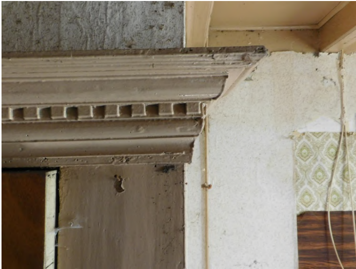
Figuur 21 - geprofileerde lijst met bloktandversiering.
