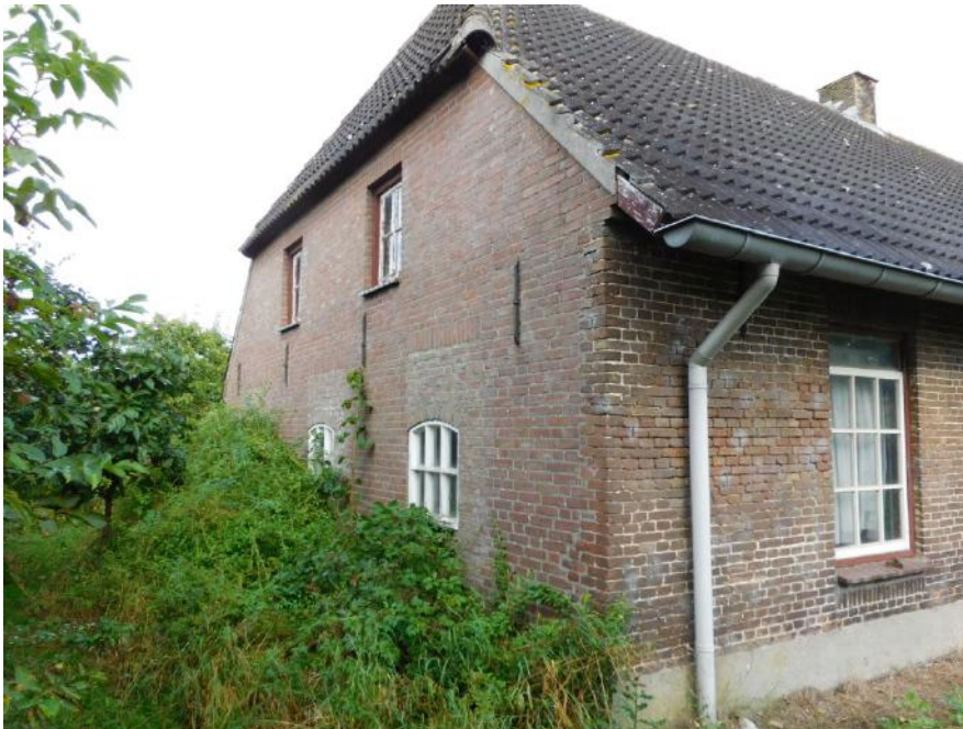
Figuur 12 - Linkers zijgevel; deze is geheel vernieuwd, waarschijnlijk in de jaren 80.
