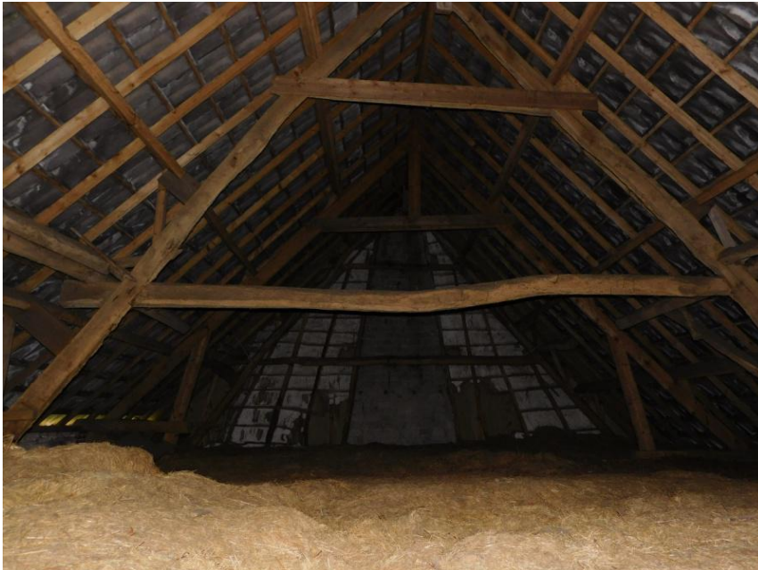
Figuur 19 - gebinten in het stalgedeelte van de boerderij Jekschotstraat 1; van het voorste gebint zijn de gebintbalkschoren verwijderd, evenals de nokstijl; in het tweede gebint is de ankerbalk verwijderd. Op de achtergrond is de brandmuur zichtbaar met de vernieuwde betonstenen schoorsteen.
