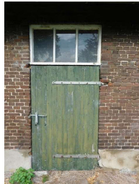
Figuur 10 - Staldeur in de voorgevel, voorzien van drieruits bovenlicht.
