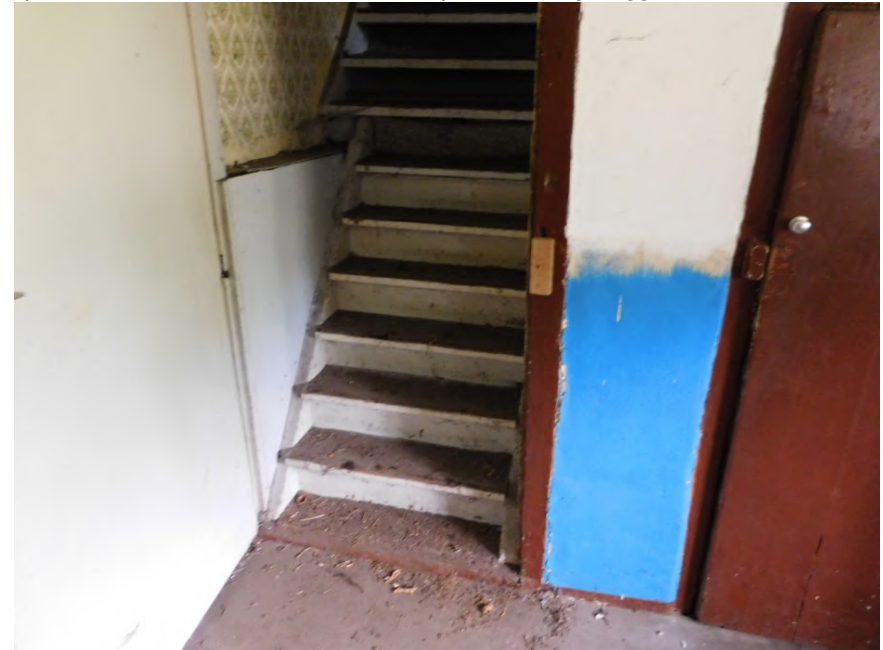
Figuur 23 - Rechts de deur naar de kelder; links de trap naar de bovenverdieping. De eerste zes treden zijn de oorspronkelijke trap naar de opkamer. Daar bovenop is later de trap doorgetrokken naar nieuwe slaapkamers op de bovenverdieping.
