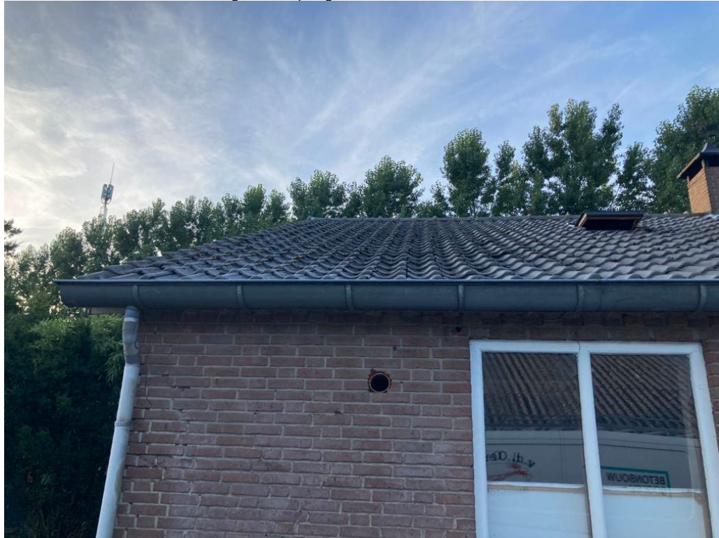
• Afbeelding 14: te slopen gebouw
