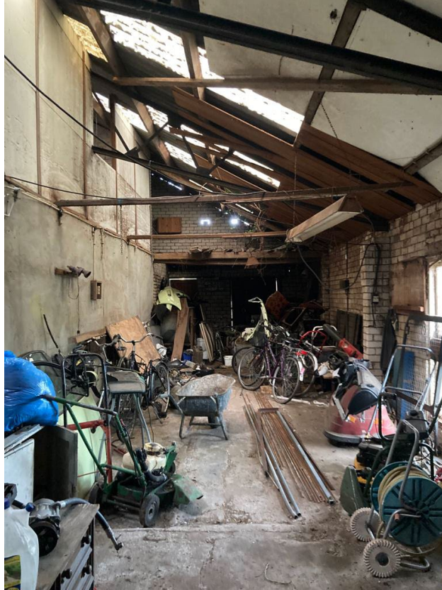
• Afbeelding 6: binnenzijde te slopen gebouw
