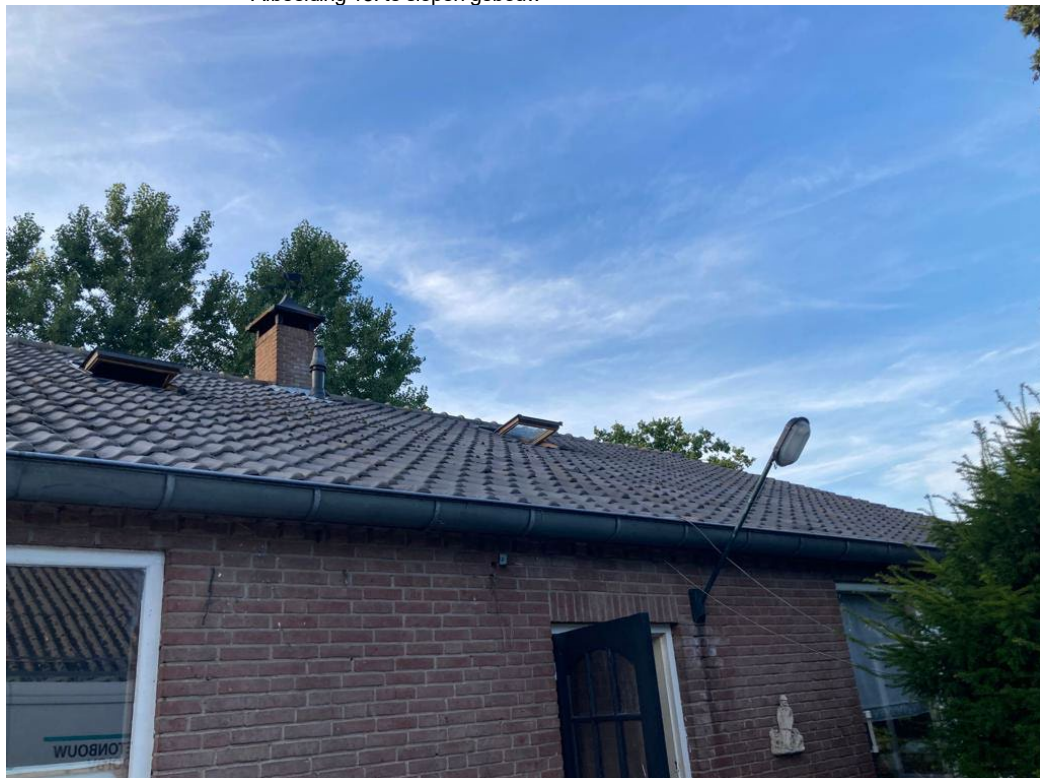
• Afbeelding 15: te slopen gebouw
