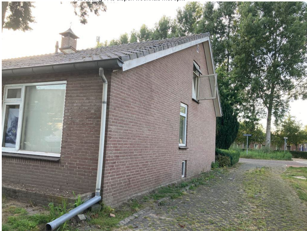
• Afbeelding 7: te slopen woonhuis met oprit
