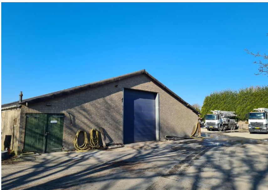
Figuur 4: Voorgevel van de opslagloods vanaf de oostzijde van het perceel
