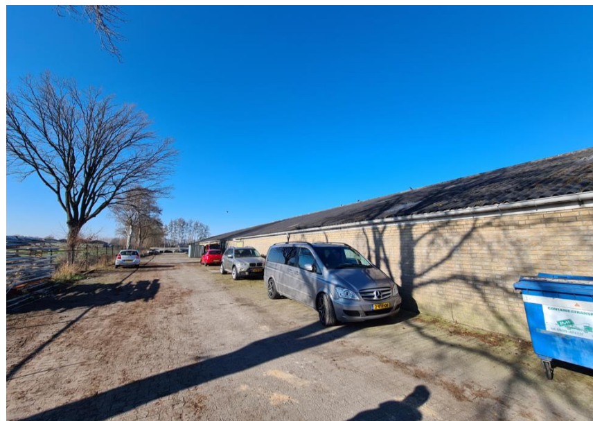
Figuur 5: Zijgevel aan de zuidoostzijde van het perceel
