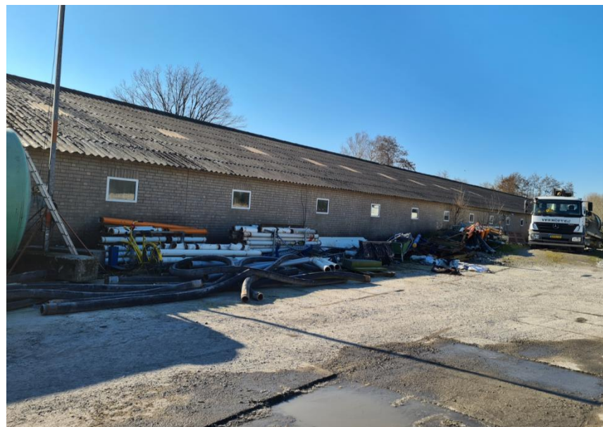
Figuur 8: Noordelijke zijgevel vanaf het noordoosten van het perceel
