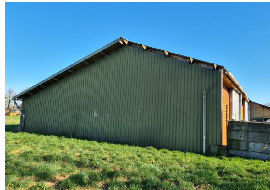
Figuur 6: Achtergevel van de opslagloods vanaf het westen van het perceel
