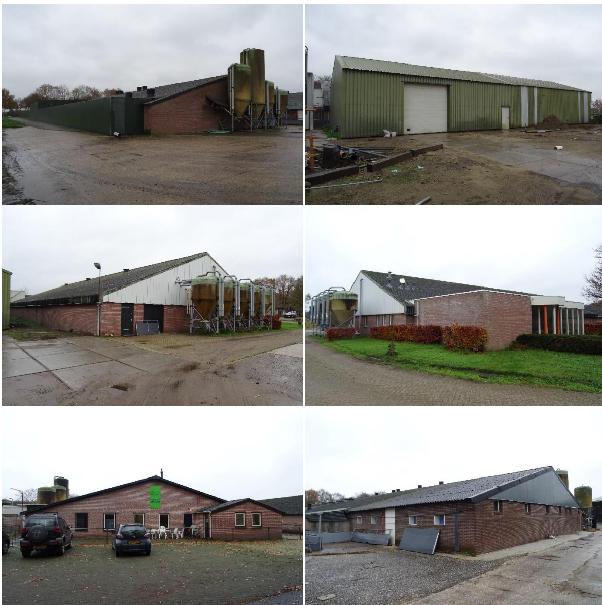
Afbeelding 3, 4, 5, 6, 7 en 8: Bestaande te slopen stallen en bijgebouwen op de kavel. Bron: R.J.L. Bijvelds 03-12-2020
