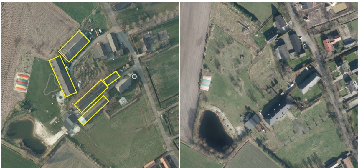
Afbeelding 9. De locatie voor en na sloop van de agrarische bedrijfsgebouwen. Geel omljnd de gebouwen die gesloopt zijn.
