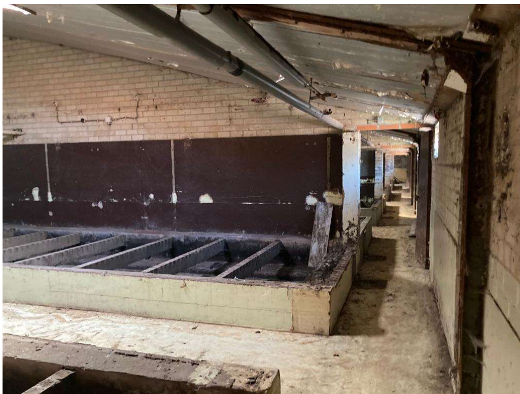
• Afbeelding 12: binnenzijde voormalige kalverenstal
