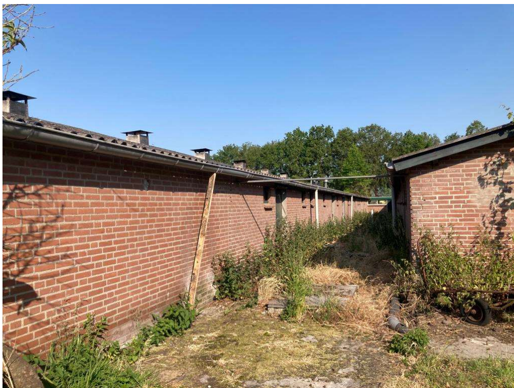
• Afbeelding 6: erfverharding tussen en rondom te slopen stallen
