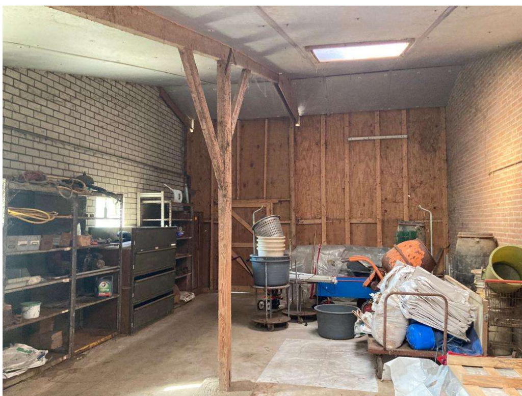
• Afbeelding 11: binnenzijde stal werkplaats
