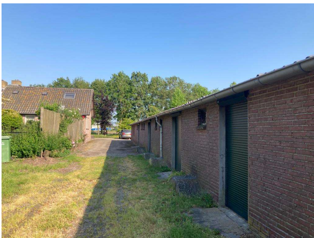
• Afbeelding 5: achterzijde bedrijfswoning, pad langs stal, zijgevel te slopen stal
