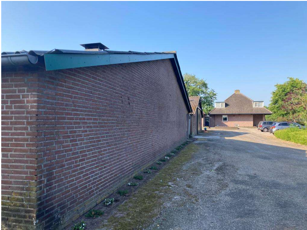
• Afbeelding 8: Voorzijde stallen en erfverharding, op achtergrond zijgevel bedrijfswoning
