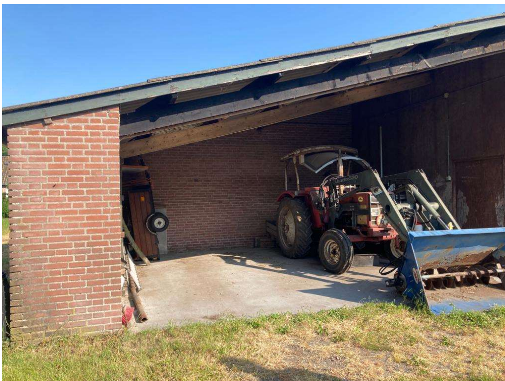
• Afbeelding 16: Loods in verlengde van de stal
