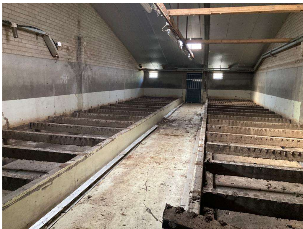
• Afbeelding 13: binnenzijde voormalige kalverenstal
