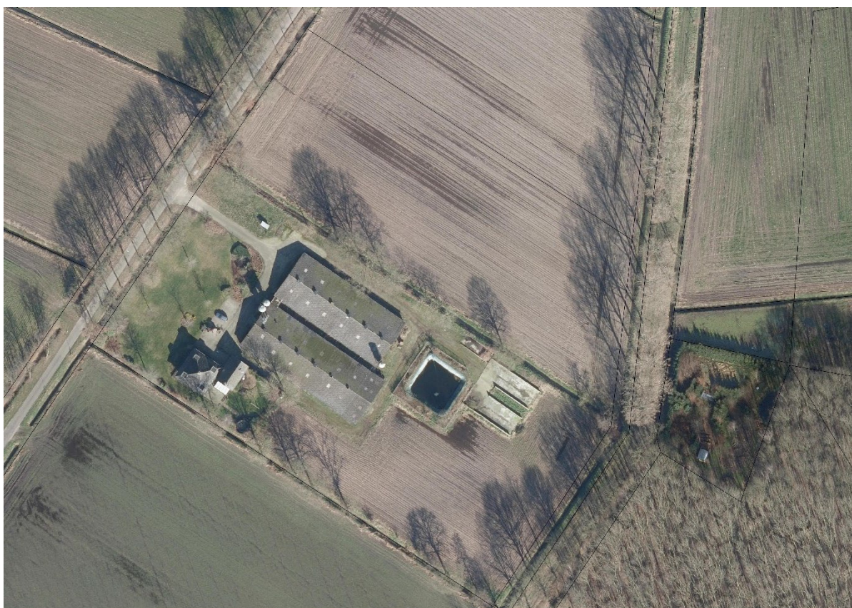
Figuur 2. Luchtfoto van bedrijfslocatie
