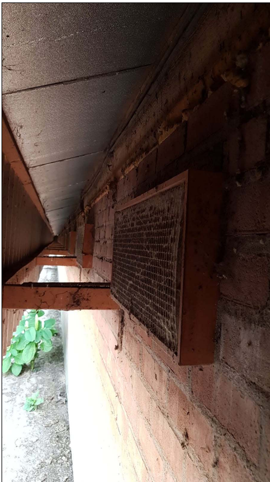
Noordzijde te slopen stallen
