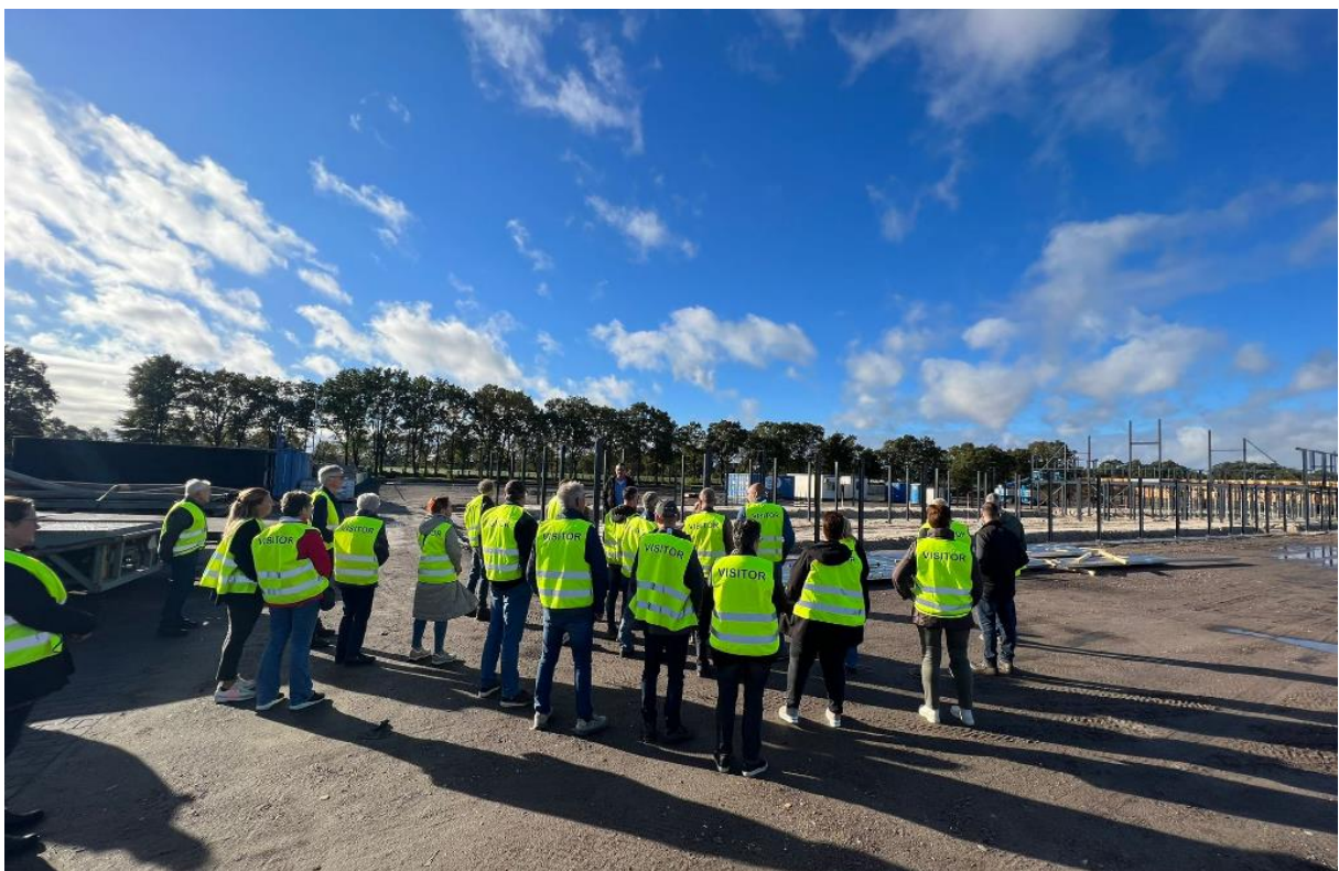
Rondleiding op de locatie waar de bouw van de huisvesting is gestart.
