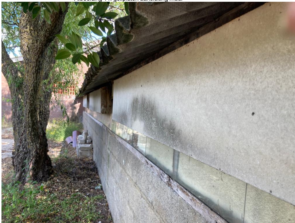
• Afbeelding 11: golfplaten aansluiting muur
