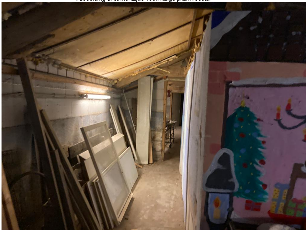
• Afbeelding 5: binnenzijde voormalige pluimveestal
