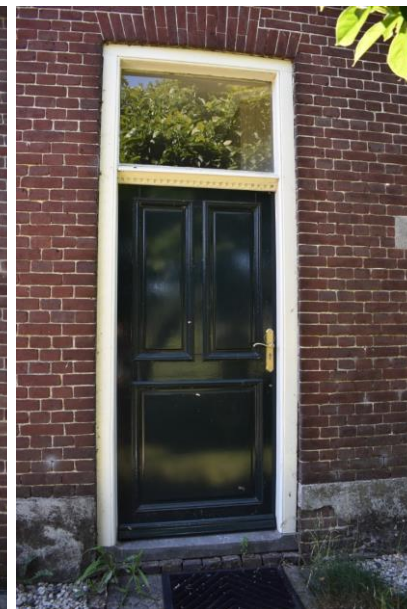
Voordeuropening met later toegevoegde deur.
