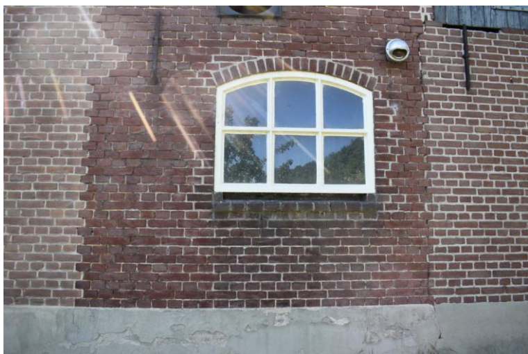
Getoogd betonnen zesruits stalvenster onder rollaag met bakstenen raamdorpelstenen met daarboven een later
