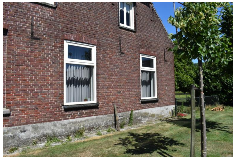
Vernieuwde houten vensters met bovenlicht onder hanenkam en geglazuurde raamdorpelstenen.
