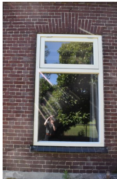
Vernieuwd houten venster met bovenlicht (links).
