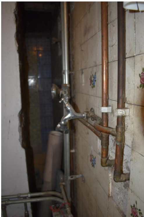
Tegels uit vermoedelijk 1904 geplaatst onder de schoorsteenboezem (aan de achterzijde) en tegels uit vermoedelijk de tweede kwart van de twintigste eeuw (aan de voorzijde).
