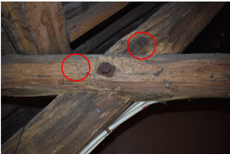
Verbinding door middel van een bout en moer. De rode cirkels wijzen het telmerk in de vorm van een halve maan aan.
