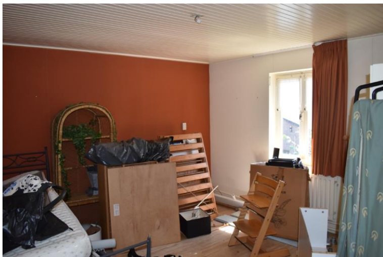
Slaapkamer op de eerste verdieping.
