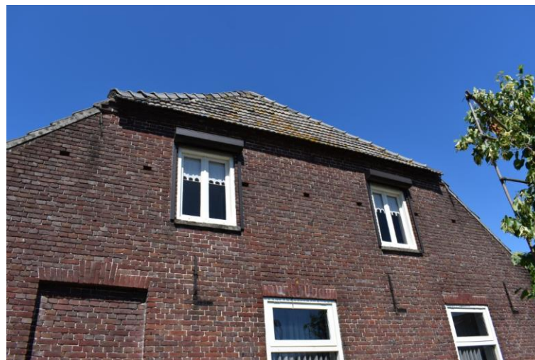
Eerste verdieping linkerzijgevel met stolpramen en later toegevoegde rolluiken.
