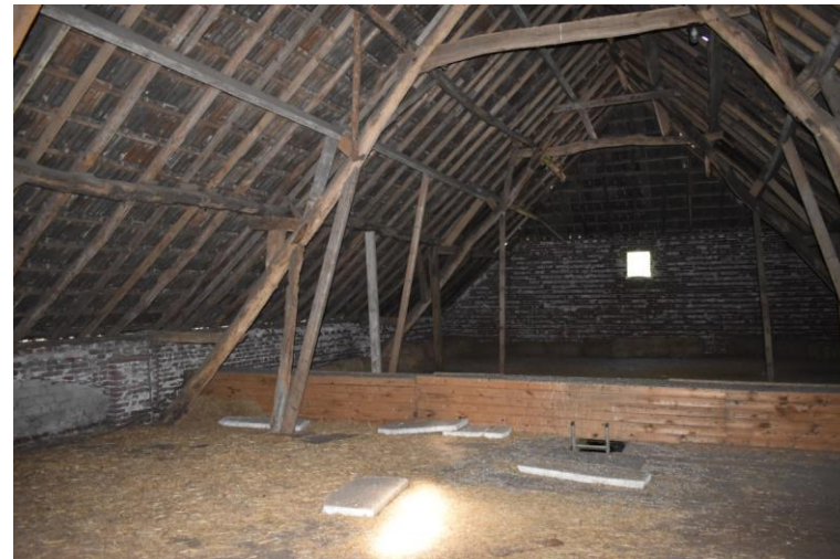
Twee achterste spanten richting de rechterzijgevel gezien.
