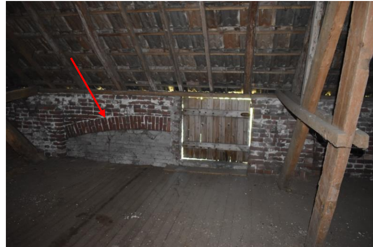
De rode pijl wijst de rollaag en opening van de voormalige dwarsdeeldeur aan.
