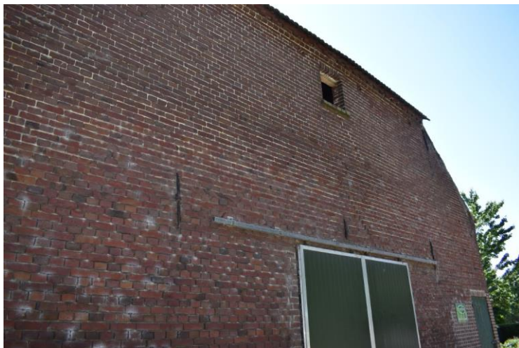
Raamopening op de eerste verdiepingvloer.
