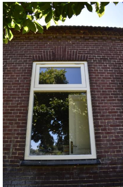
Vernieuwd houten venster met bovenlicht (rechts).
