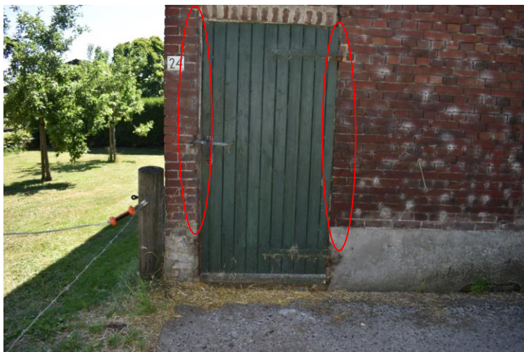
Opgeklampte houten staldeur onder rollaag (links). De rode cirkel geeft de sporen in het metselwerk aan.
