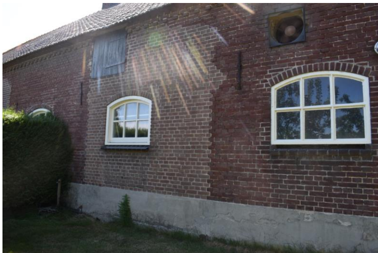
Vernieuwd getoogd houten zesruits stalvenster onder rollaag met geglazuurde raamdorpelstenen met daarboven een later geplaatst hooiluik (links).
