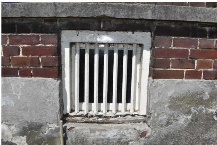
Kelderraam onder de opkamer.
