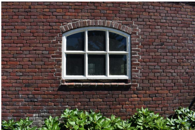
Getoogd zesruits betonvenster onder rollaag met bakstenen raamdorpelstenen.
