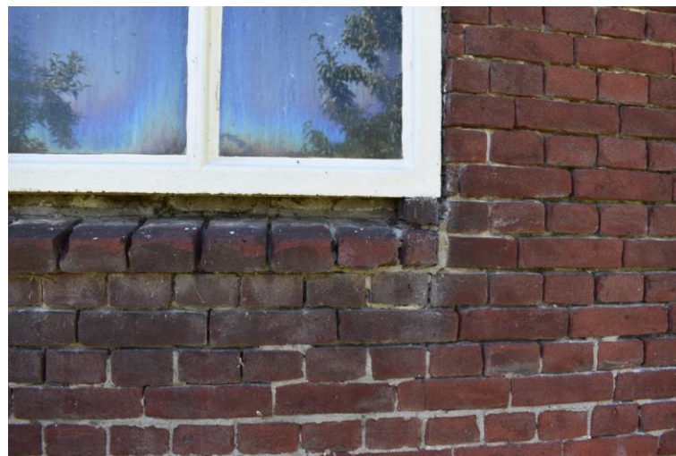
Bakstenen dorpel onder getoogd betonnen zesruits stalvenster.
