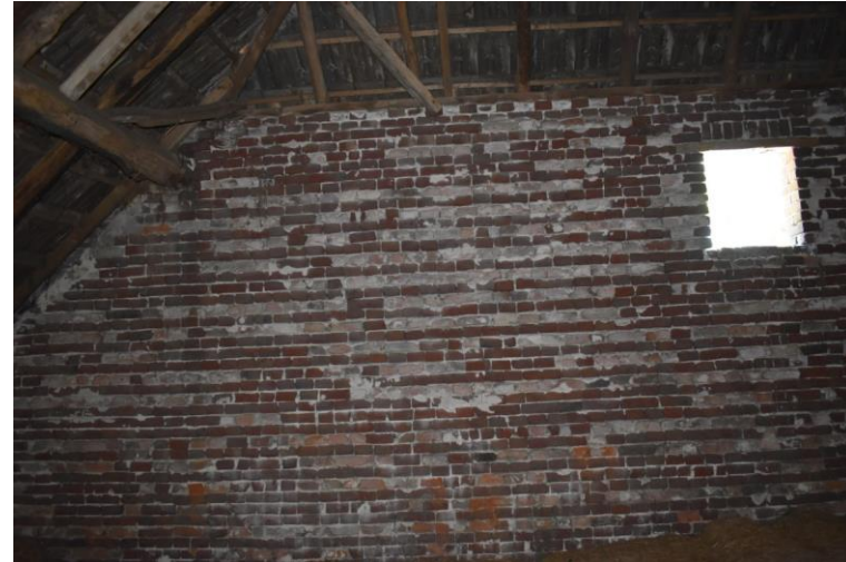
Rechterzijgevel vanuit het interieur gezien.
