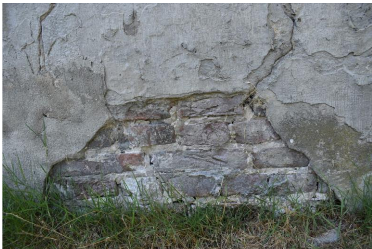
Gecementeerde plint met daarachter de bakstenen gevel.
