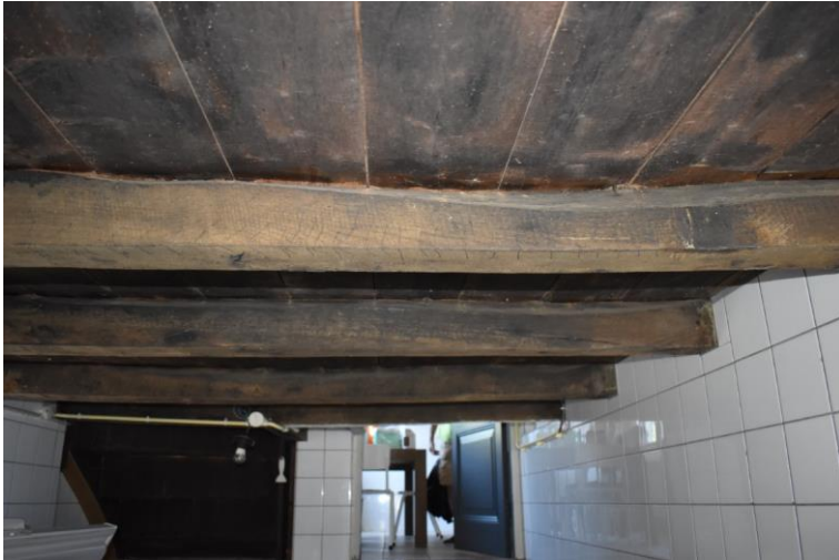
Kelder met balkenconstructie vermoedelijk uit 1904.
