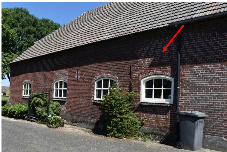
Links de drie zesruits betonvensters. Rechts het vernieuwd getoogd houten zesruits stalvenster. De pijl wijst de dichtgemetselde dubbele dwarsdeeldeur aan.
