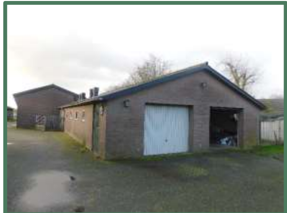
Te behouden garage en kapschuur
