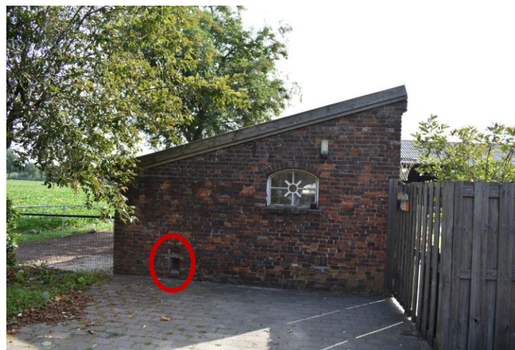
Kopgevel aan de straatzijde met in de cirkel de sparing voor de kippen
