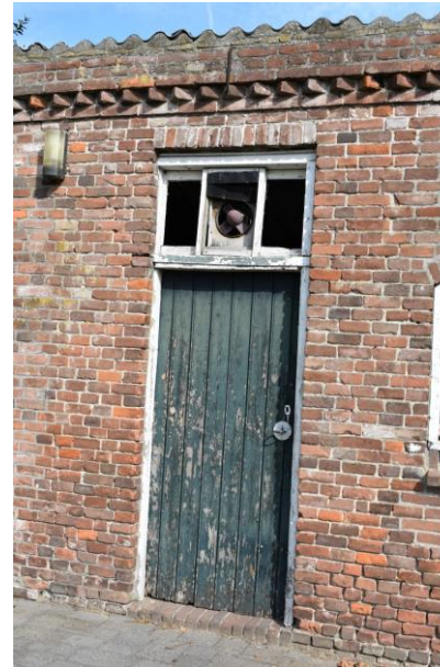
De toegangsdeur met bovenlicht die ook zichtbaar is op de foto uit 1944
