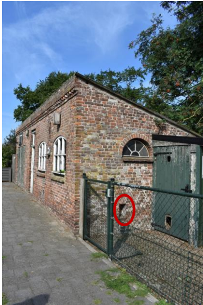
Achtergevel met sparing voor de kippen
