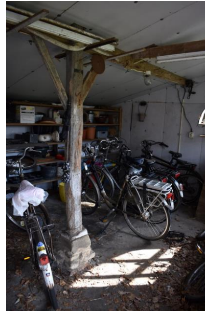
Houten staanders met korbelen deels opgebouwd uit hergebruikt materiaal
