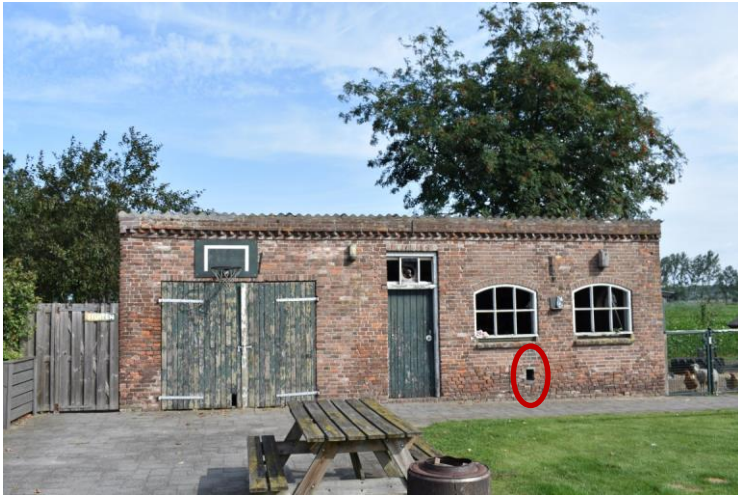
Rechterzijgevel waarin rond de dubbele deuren en de zesruits-vensters wijzigingen zichtbaar zijn. In de cirkel de sparing voor de kippen
