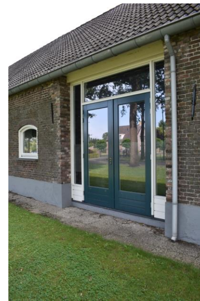
Nieuwe puivulling ten platse van de deeldeuropening
