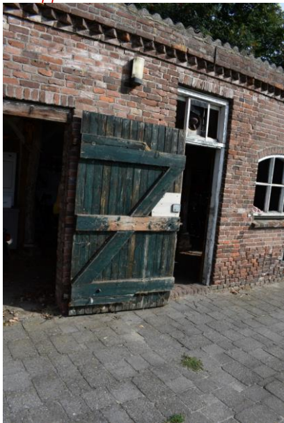
Opgeklampte dubbele deuren
