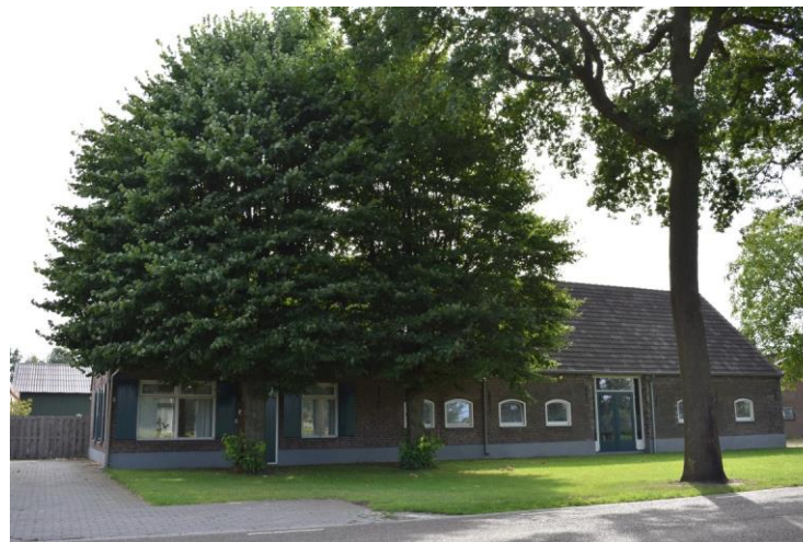
Voorgevel van de langgevelboerderij
