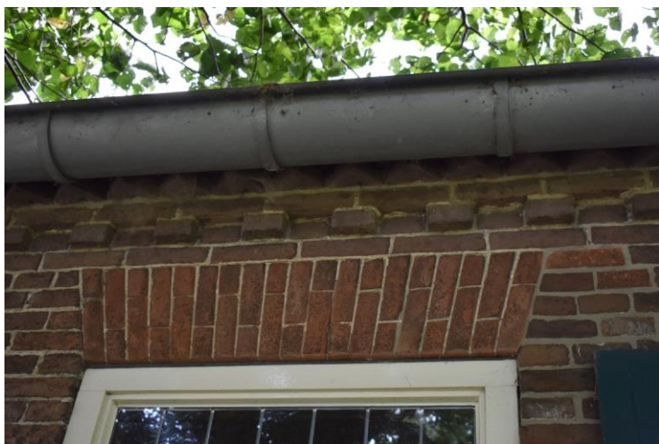
Overhoekse muizentand en bloktand als siermetselwerk onder de goot
