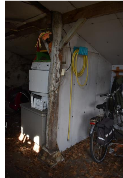
Houten staanders met korbelen deels opgebouwd uit hergebruikt materiaal
