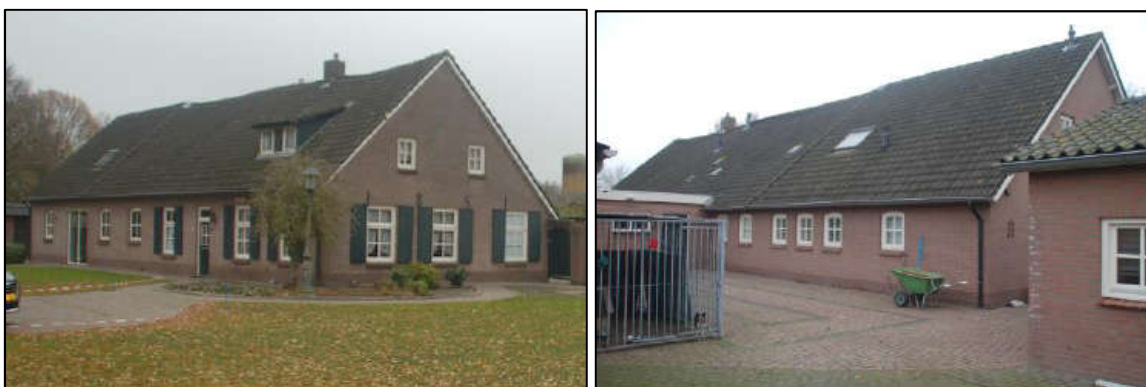
Figuur 12: Voor- en achterzijde bedrijfswoning
