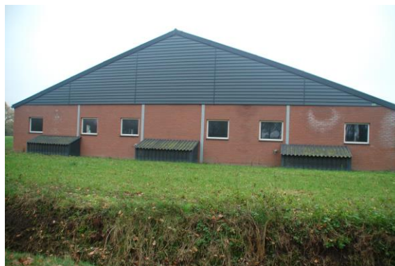
Stal 4 voorgevel met luchtinlaten
