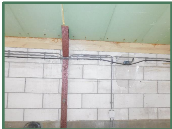
Afgesloten luchtinlaat binnenzijde stal
