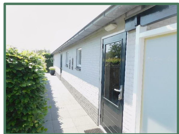
Overzicht zuidelijke zijgevel stal
