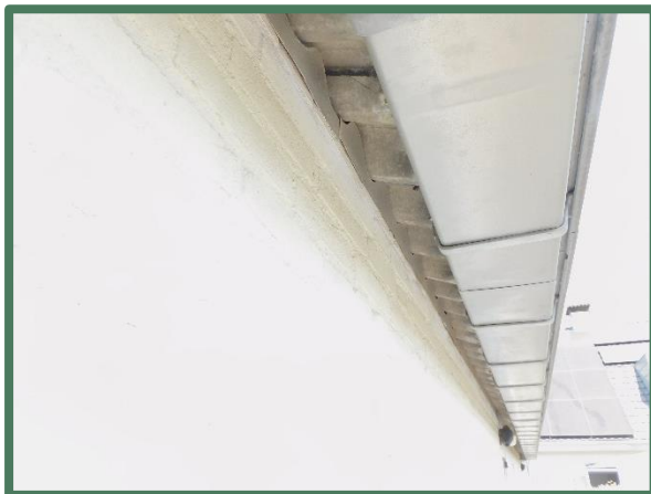
Afgesloten dakrand onder de goot van stal
