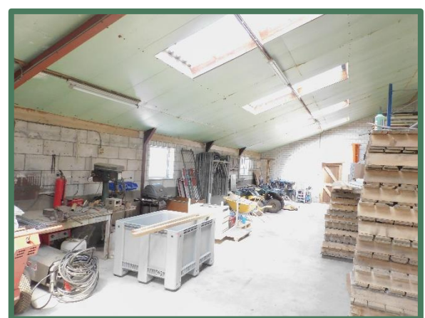
Binnenzijde te slopen stal
