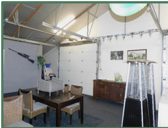
Binnenzijde te slopen stal
