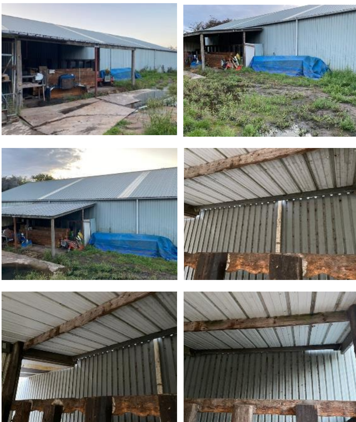
Figuur 11 Foto's bestaande situatie ter plaatse van de beoogde overkapping (d.d. 16 september 2022)
