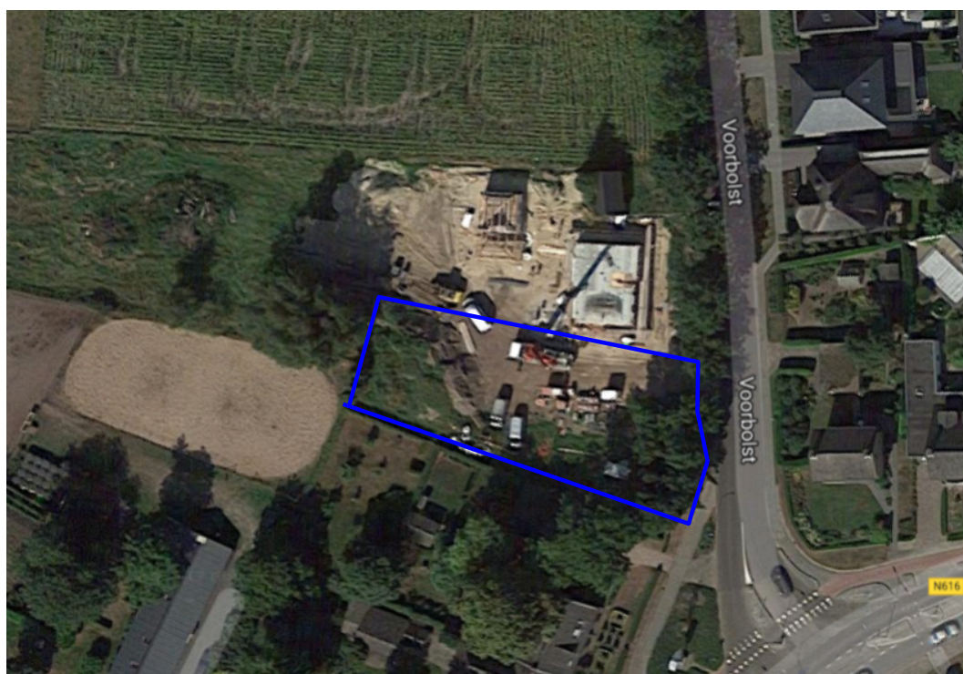
Figuur 5: Bouwwerkzaamheden naast het plangebied (Google Maps Satelliet).
