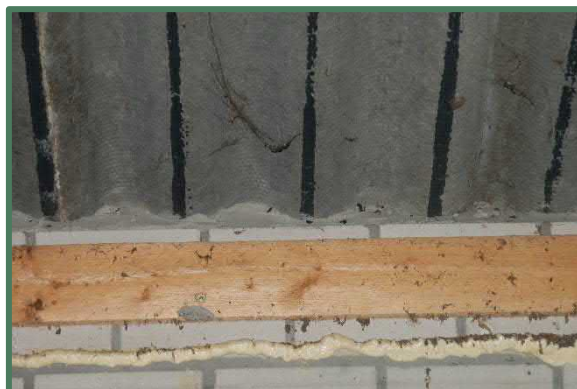
Aangesmeerde golven boven de muur van de golfplaten met muurplaat
