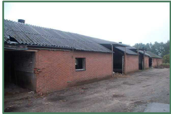
Oostelijke zijgevel stal 4
