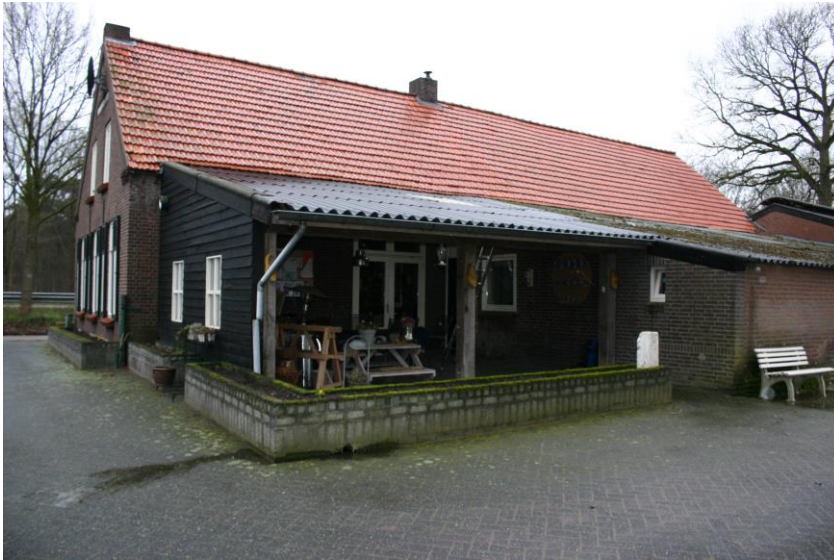
Figuur 4.2.1. Tegen de boerderij is een veranda gebouwd.
