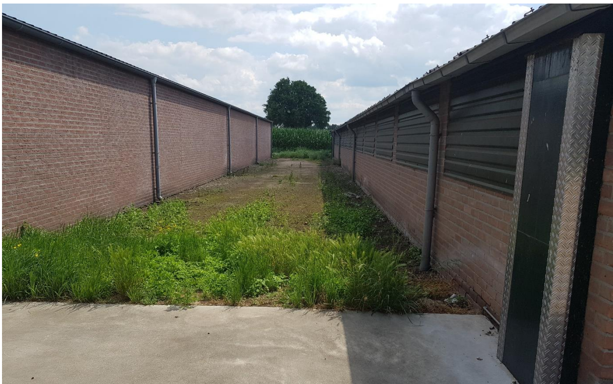
Zicht op strook tussen stal 2 en stal 1
