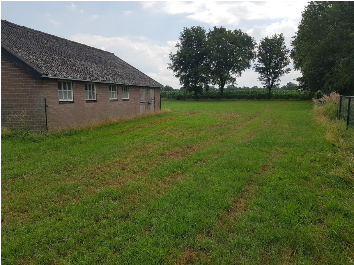
Zicht op zuidwestzijde paardenstal
