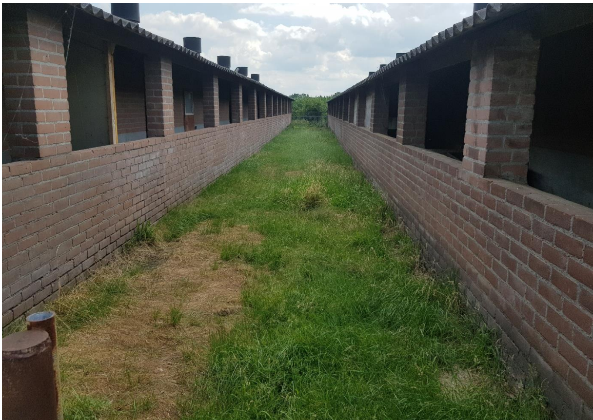
Zicht op strook tussen stal 2 en 3
