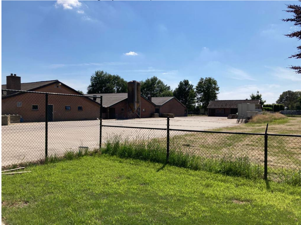
• Afbeelding 3: zij aanzicht te slopen stallen
