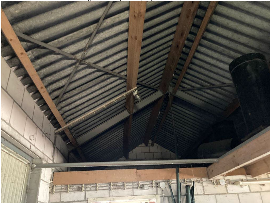
• Afbeelding 14: binnenzijde te slopen paardenstal
