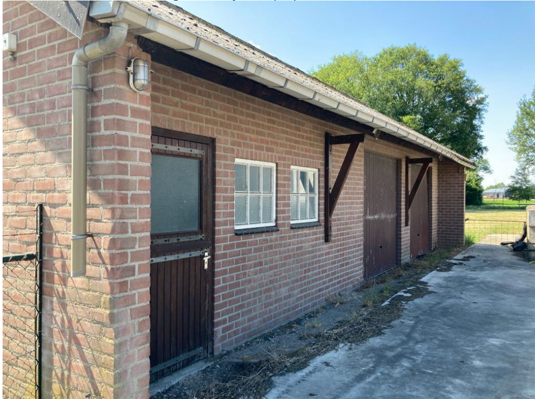
• Afbeelding 16: buitenzijde te slopen paardenstal
