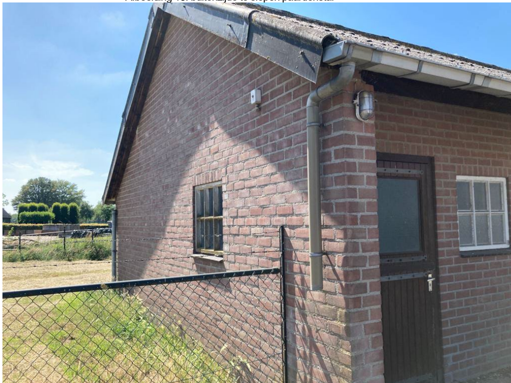
• Afbeelding 15: buitenzijde te slopen paardenstal
