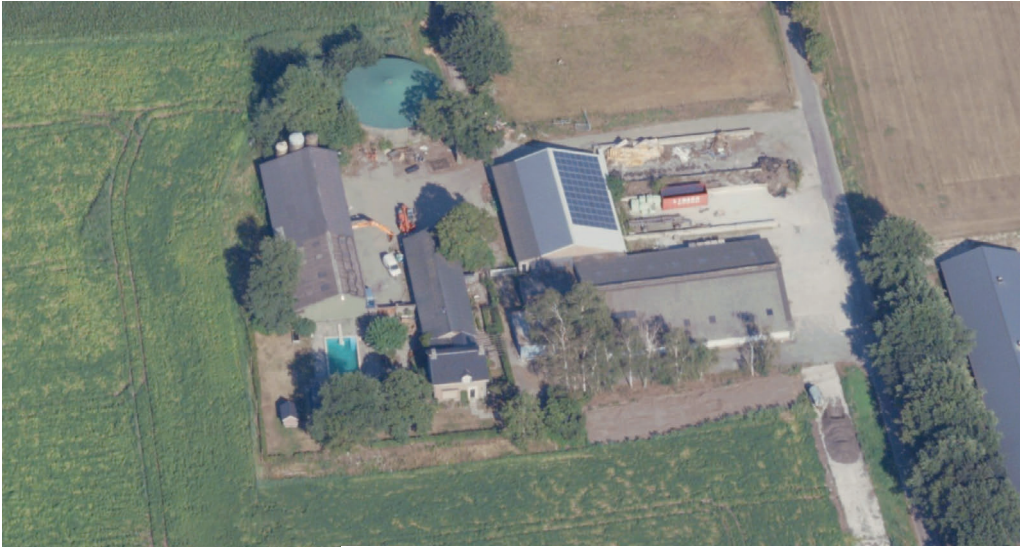
Obliëk luchtbeeld | zichthoek vanuit oosten - Cyclomedia
