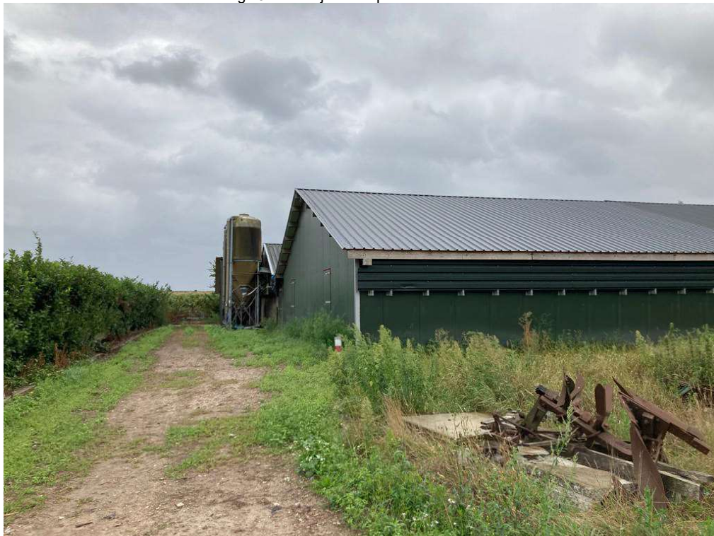
• Afbeelding 25: buitenzijde te slopen varkensstallen
