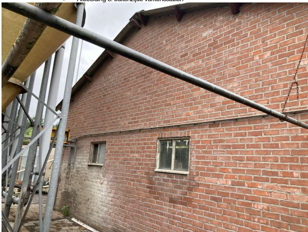
• Afbeelding 8: buitenzijde varkensstallen
