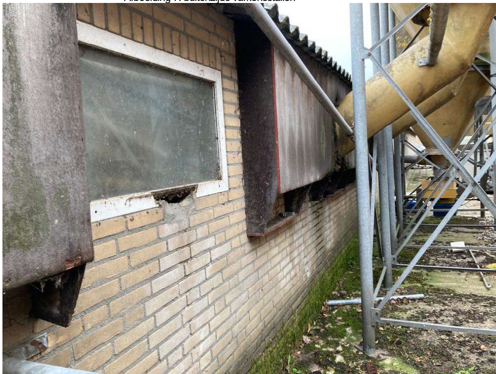
• Afbeelding 7: buitenzijde varkensstallen
