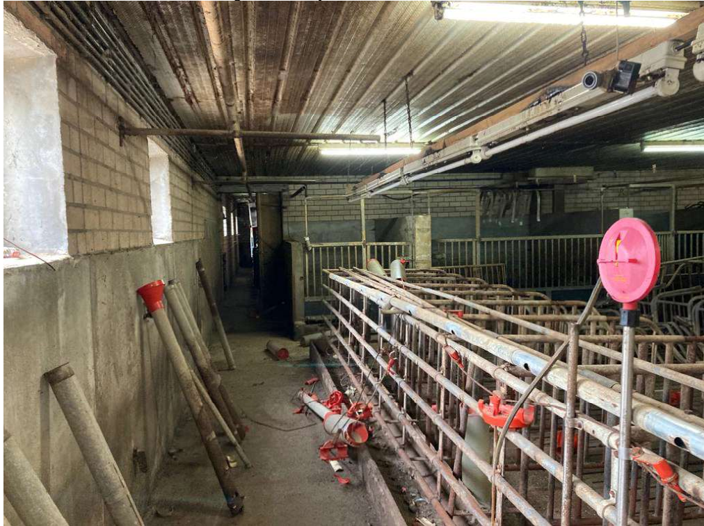
• Afbeelding 11: binnenzijde varkensstallen
