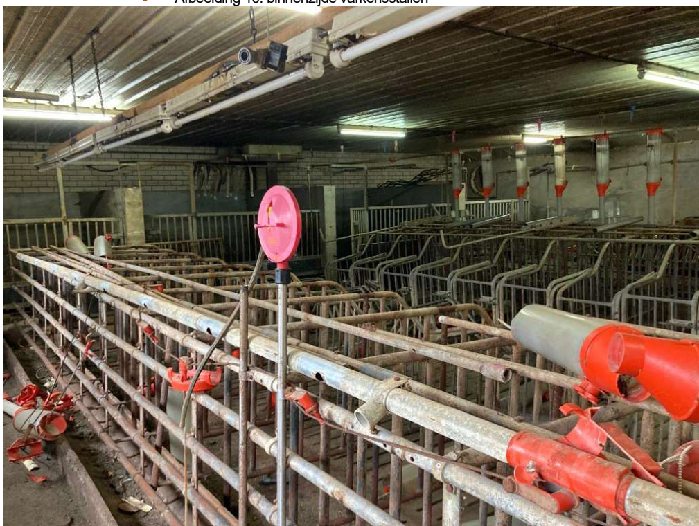
• Afbeelding 10: binnenzijde varkensstallen
