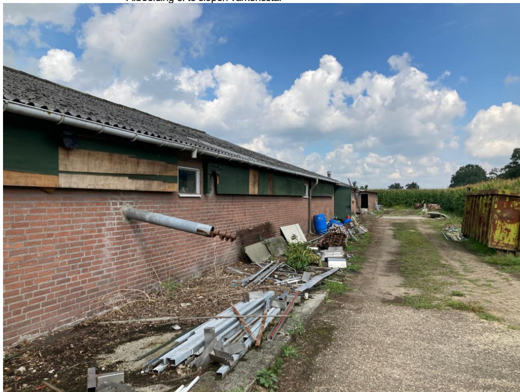
• Afbeelding 6: te slopen varkensstal
