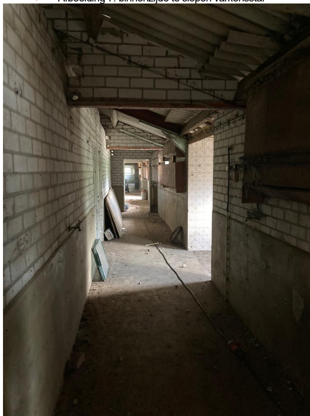
• Afbeelding 7: binnenzijde te slopen varkensstal
