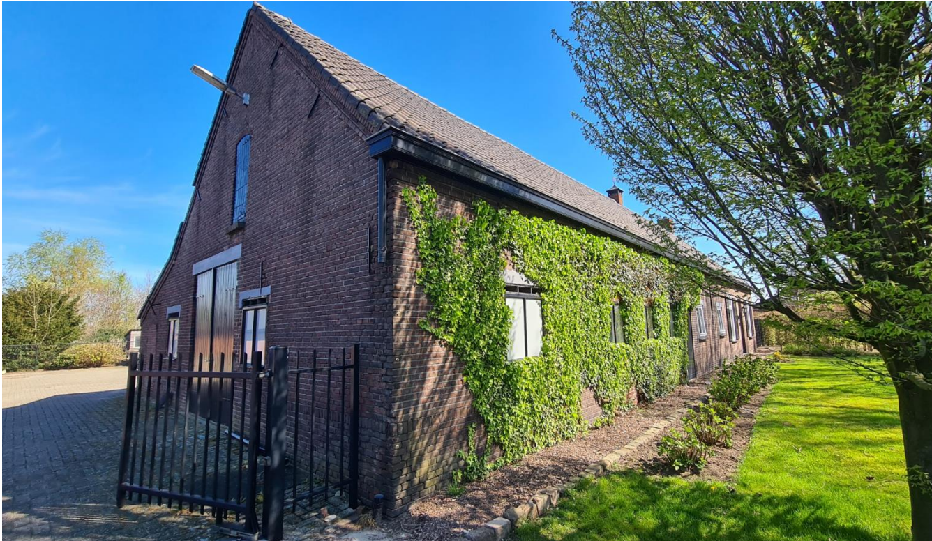
Figuur 1: Langgevelboerderij in het zuidoosten van het plangebied
