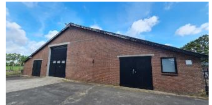
Figuur 5: Zuidgevel stallen
