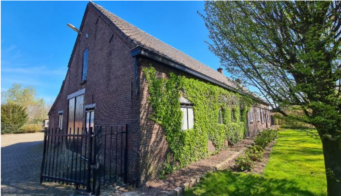
Figuur 3: Langgevelboerderij in het zuidoosten van het plangebied
