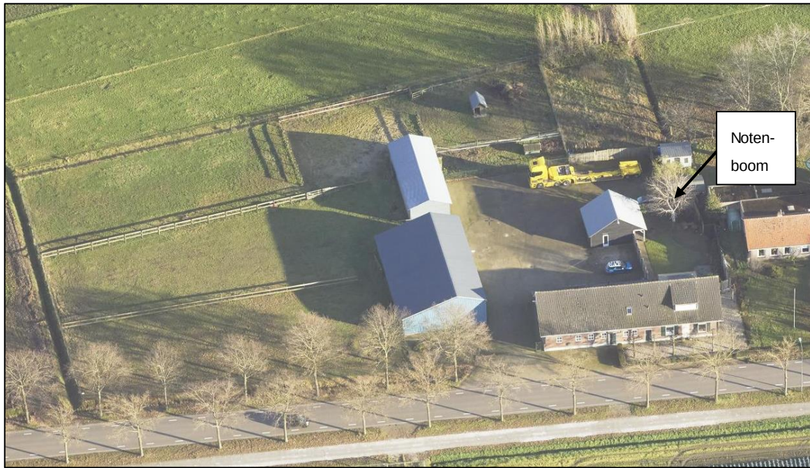
Figuur 9: Luchtfoto van het plangebied, datum december 2020 waaruit blijkt dat er behoudens de landschappelijke boom geen landschappelijke inpassing aanwezig is
