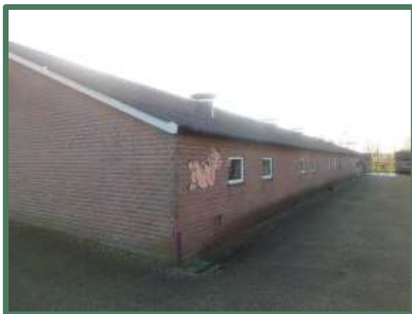
Voorzijde (oosten) stallen
