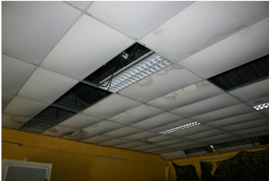
Figuur 4.4.3. Eén compartiment van de voormalige varkensstal heeft een systeemplafond.
