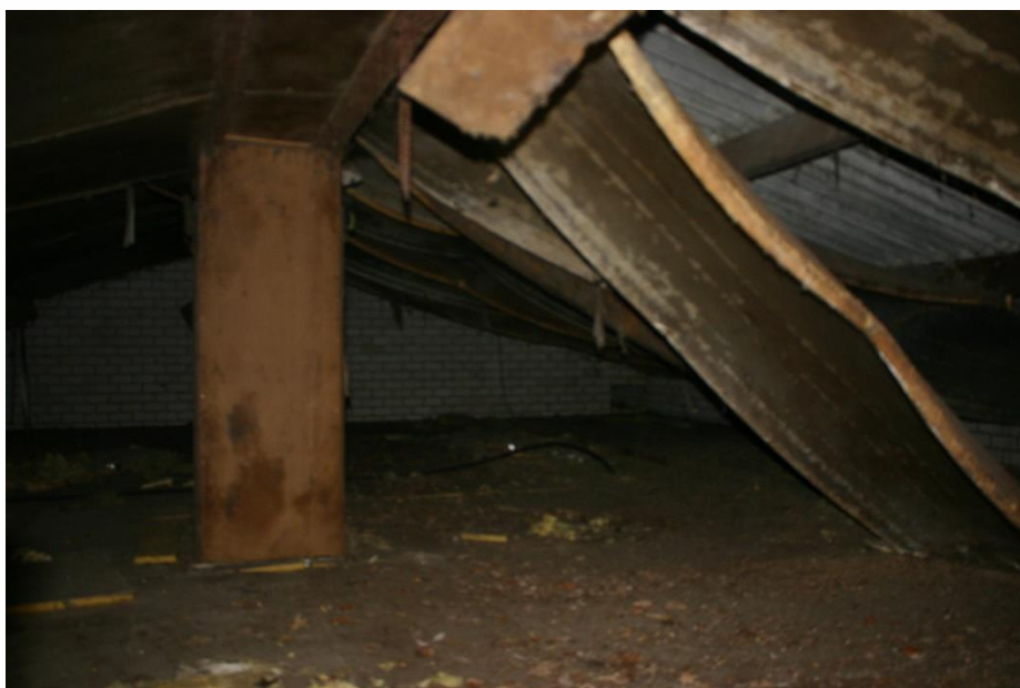
Figuur 4.4.2. Eén van de geïnspecteerde zolders.
