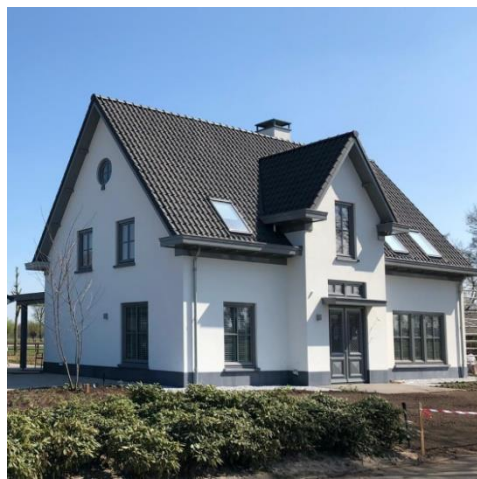
Figuur 2.4 Bedrijfswoning na renovatie
