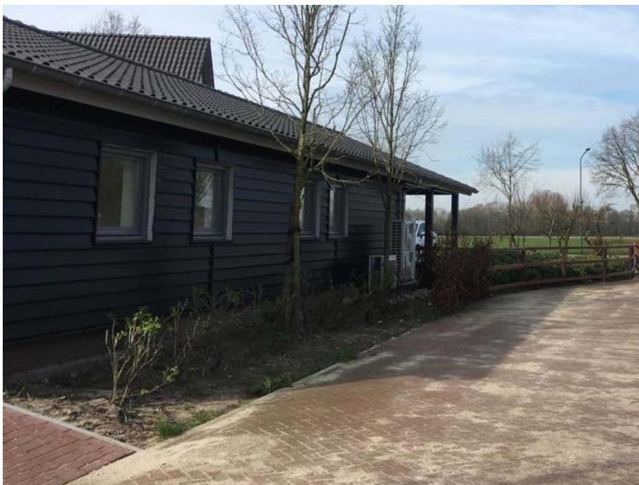
Figuur 2.8 gerenoveerde veldschuur met Kantoor / ontvangst gasten en werktuigenloods
