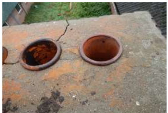
Gemetselde schoorstenen met gres buizen
