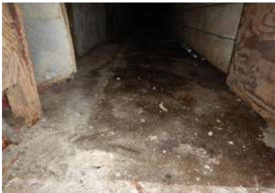
Vloer van beton
