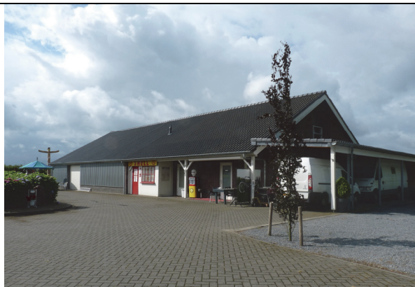
Fig. 3 Vooraanzicht hal. Het te bouwen deel ligt aan de achterzijde en zijkant van het gebouw. Foto genomen richting het zuiden.
