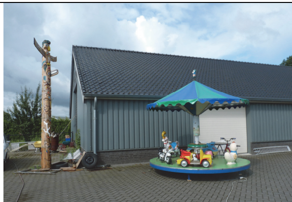
Fig. 4. Achterzijde van de hal met zicht op het deel waar de uitbreiding plaats zal vinden. Foto genomen richting het zuidwesten.
