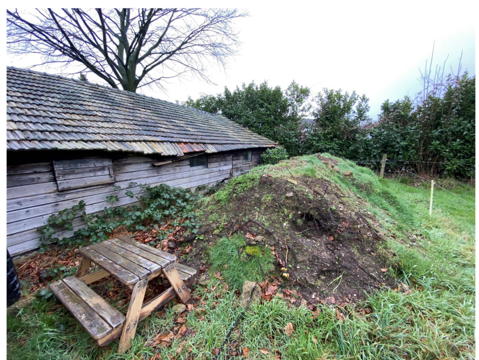
Figuur 21. Beeld van de achterzijde van loods 2 die gesloopt gaat worden.
