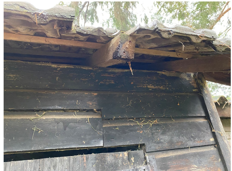
Figuur 22. Beeld van de open daken van loods 2.
