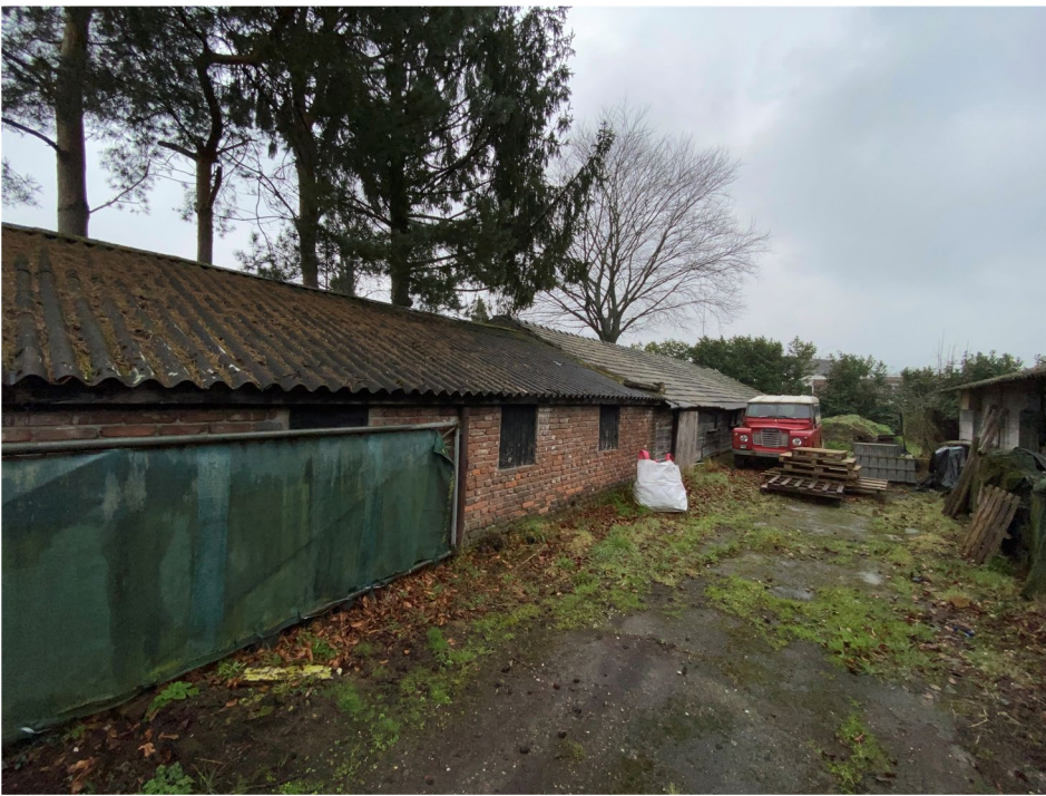
Figuur 20. Beeld van de loods 2 die gesloopt gaat worden.
