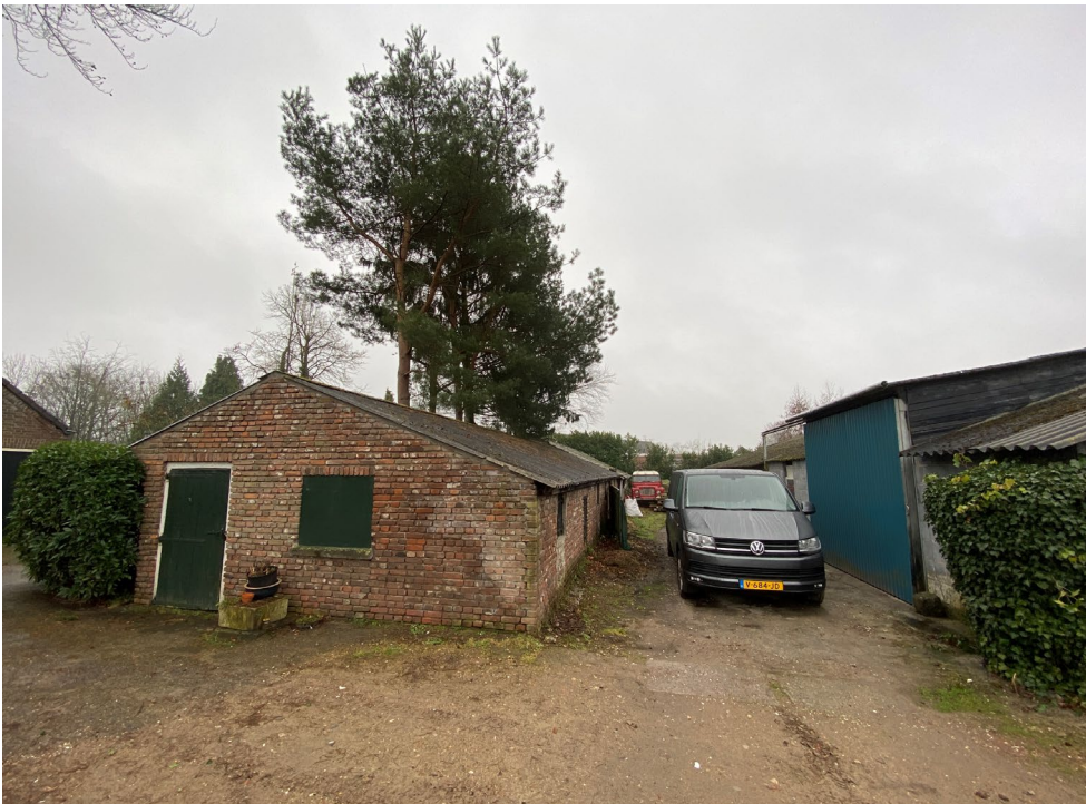
Figuur 4. Beeld van 'loods 2' (links) en loods 1 (rechts). De linker loods zal worden gesloopt.
