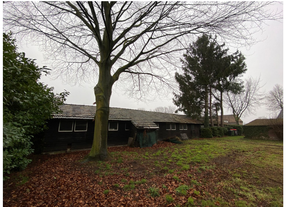
Figuur 6. Beeld van loods 2 aan de zijde van de woonboerderij aan de oostzijde.
