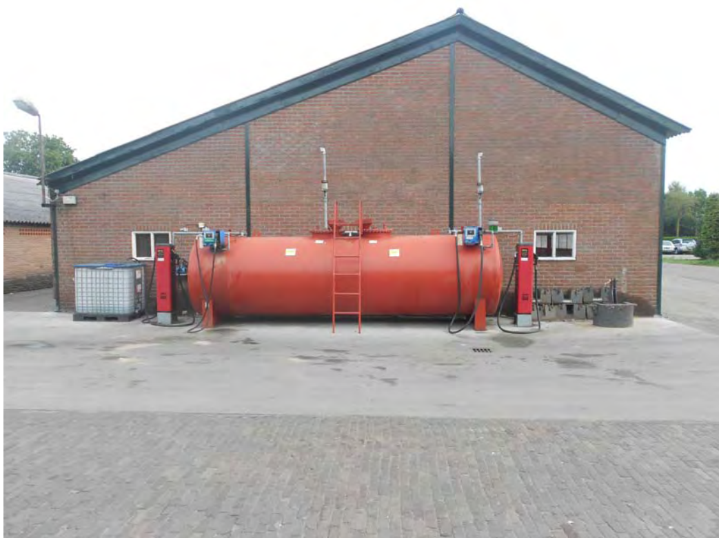
Foto 1. Tankplaats (incl. bovengrondse dieseltank)
