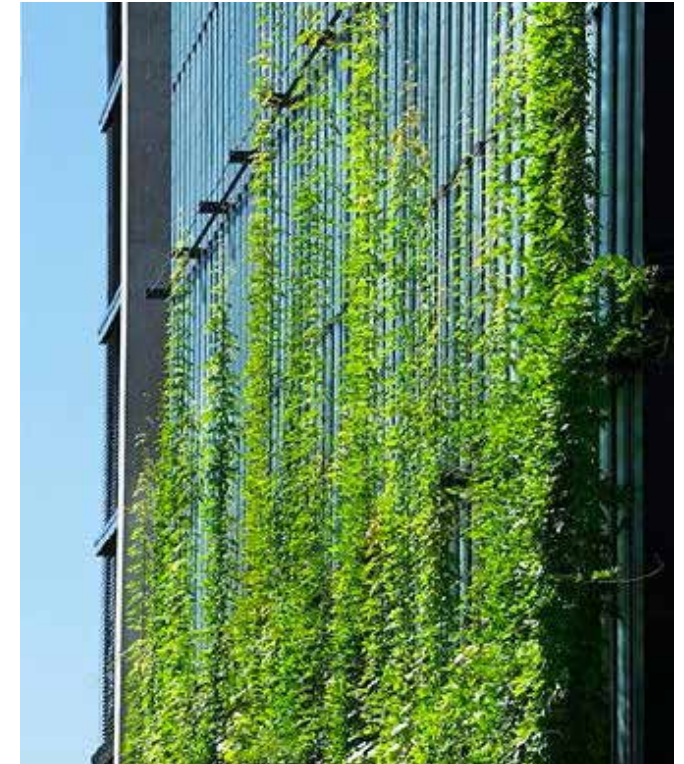
Figuur 6: Gevelbekleding met groen (Bron: Siebers tuinprojecten)
