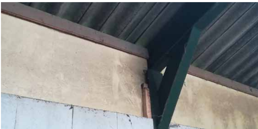
Dak en wanden schuur 2
