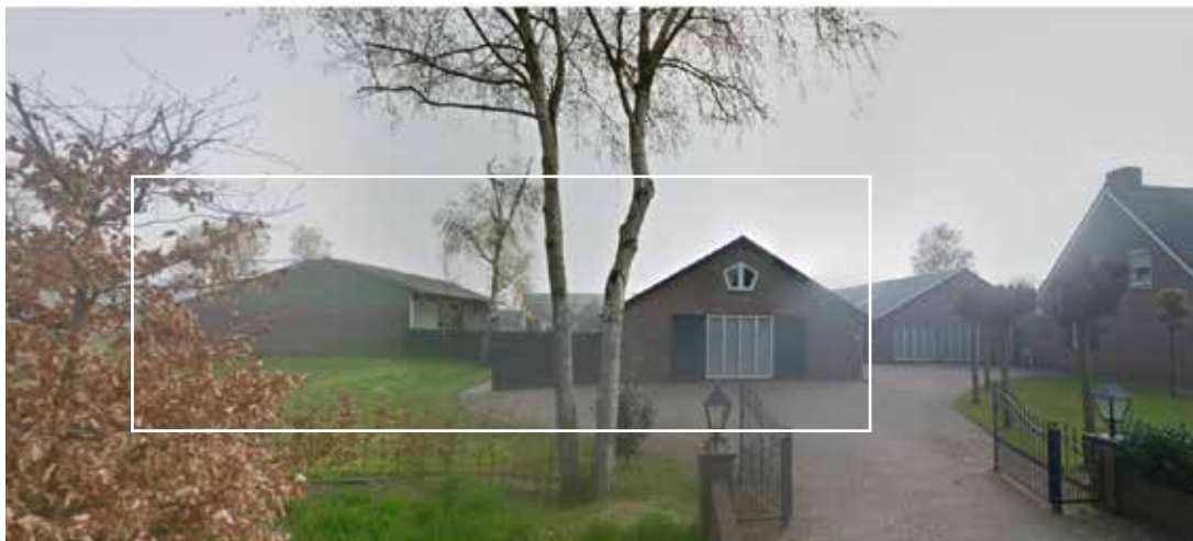
Het erf - en de te slopen schuren
