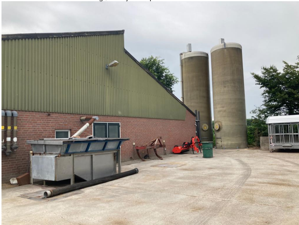
• Afbeelding 5: voorzijde te slopen varkensstal
