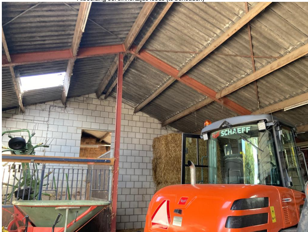
• Afbeelding 33: binnenzijde loods (te behouden)
