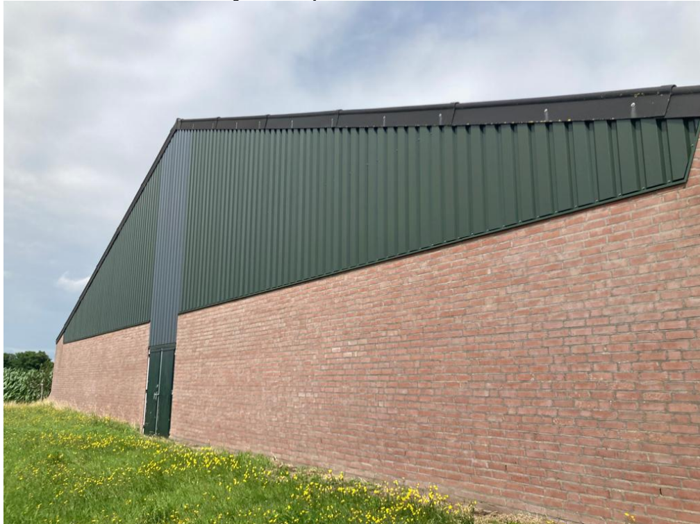
• Afbeelding 20: buitenzijde varkensstallen
