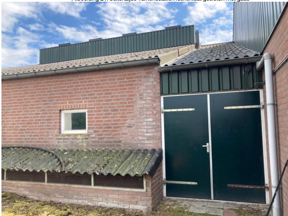
• Afbeelding 21: buitenzijde varkensstallen luchtinlaat gesloten met gaas
