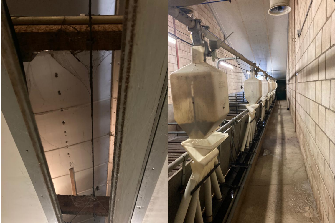
• Afbeelding 28 en 29: binnenzijde volledig geïsoleerd
