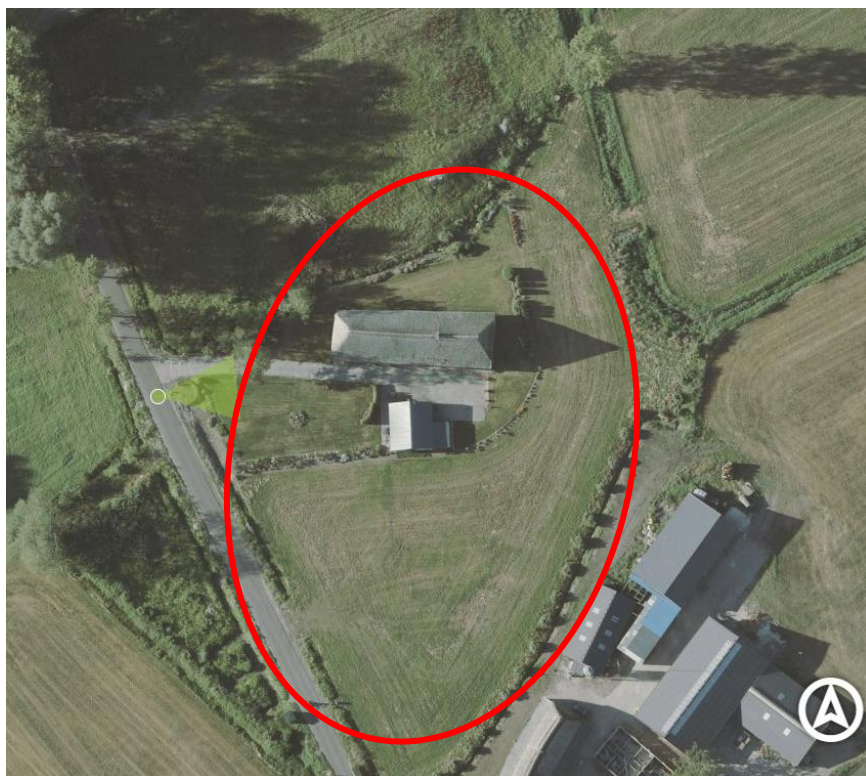
Figuur 3b: projectlocatie Borne 46 te Schijndel, na sloop van de stallen.
