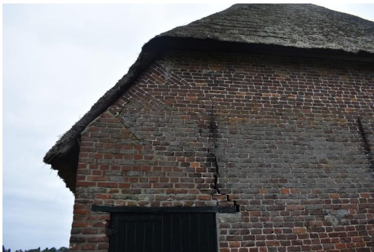
Linker gedeelte van de linkerzijgevel.
