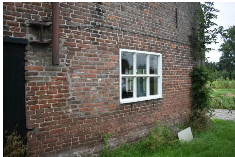
Later aangebracht betonnen zesruits stalvenster in linkerzijgevel.
