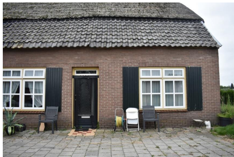
Dubbel vierruits vensters met tweeruits bovenlicht.
