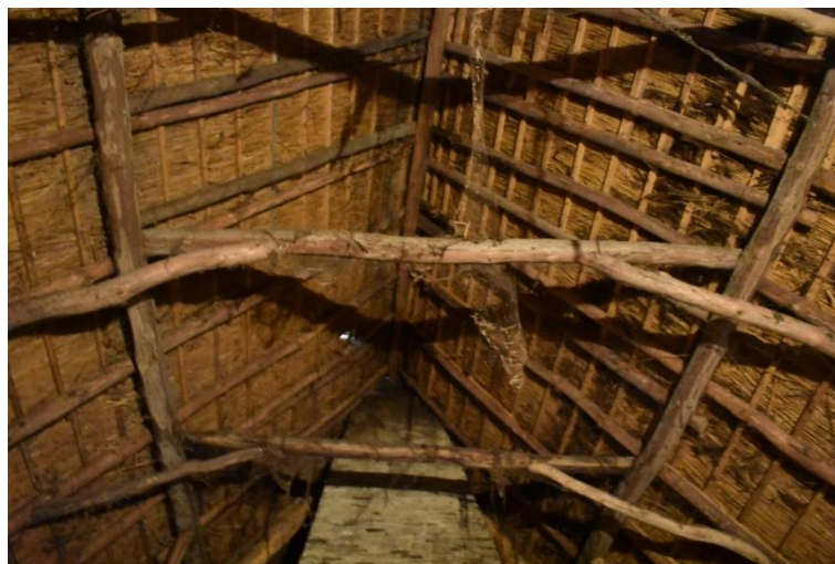
Rondhouten spanten ter plaatse van het woongedeelte.
