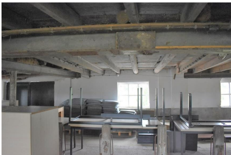
Stalruimte machinaal gezaagde houten constructie.
