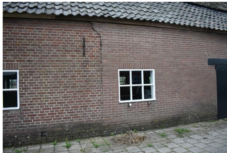
Betonnen zesruits stalvenster.
