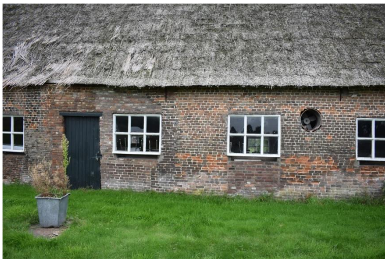
Staldeur en betonnen zesruits vensters.
