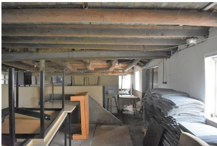
Stalruimte met rondhoutenconstructie.
