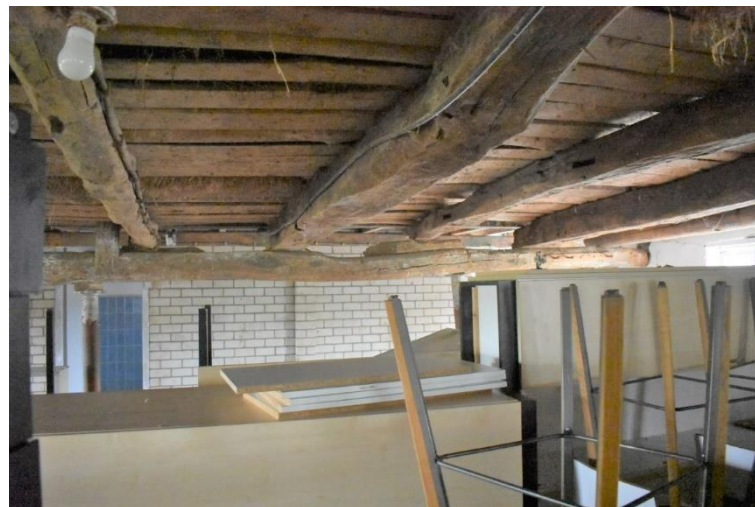
Stalruimte geslagen houten constructie.
