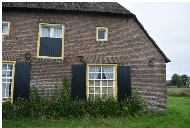
Rechterzijde van de rechterzijgevel.
