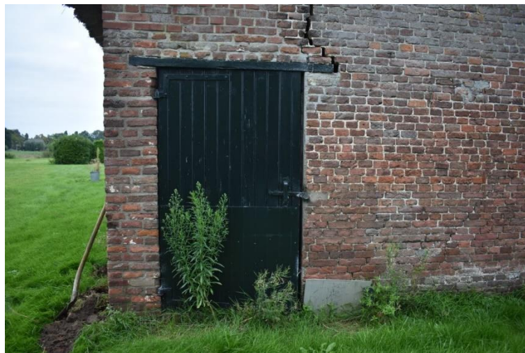
Staldeur onder betonlatei.
