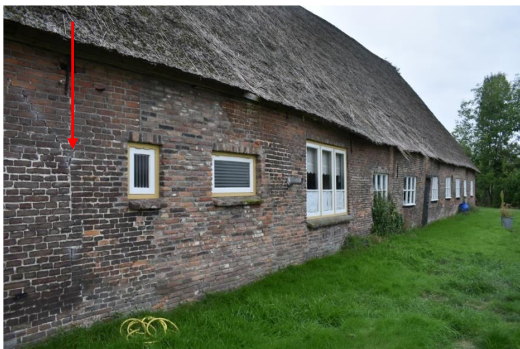
Bouwnaad, toiletvenster en badkamerraam.
