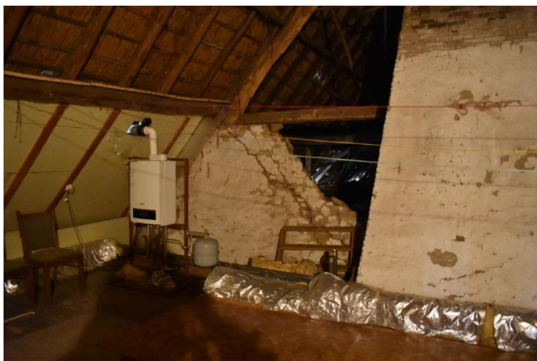
Gemetselde brandmuur en rookkanaal.
