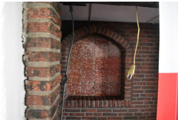
Een later gemetselde nis met enkele schildpadtegels, te dateren tussen 1750 en 1930.
