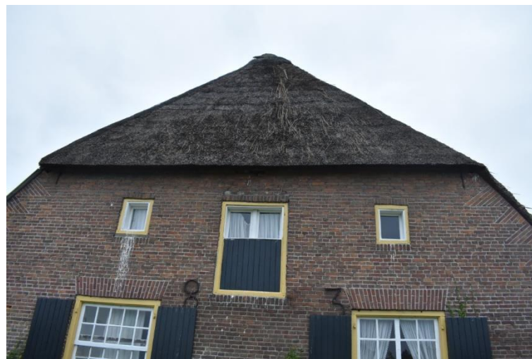
Eerste verdieping rechterzijgevel.
