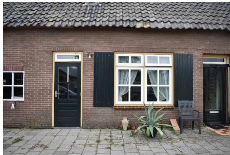
Paneeldeur met bovenlicht.
