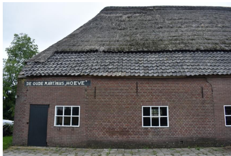
Stal deur en betonnen zesruits stalvensters.
