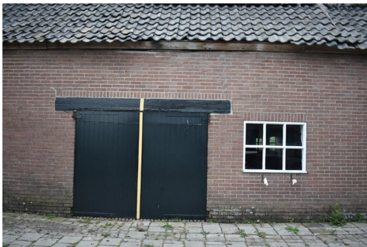
Dubbele staldeur onder betonlatei.
