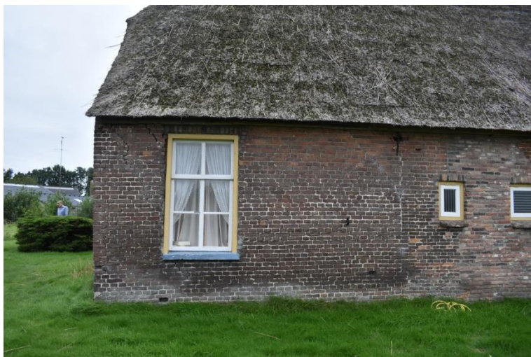
Houten zesruits venster en metselwerk uit het eind van de negentiende eeuw.
