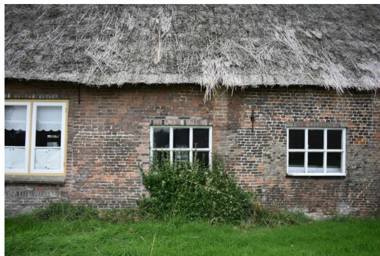
Betonnen zesruits stalvensters onder rollaag.
