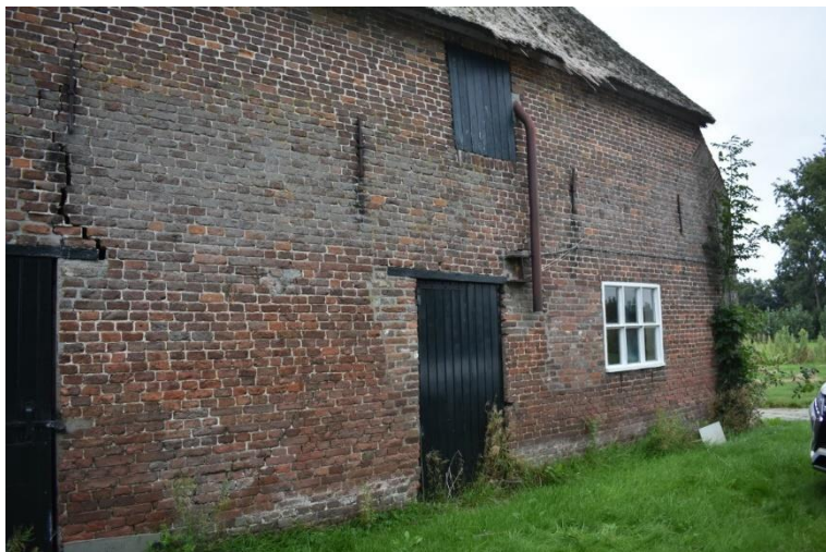
Staldeur onder betonlatei.
