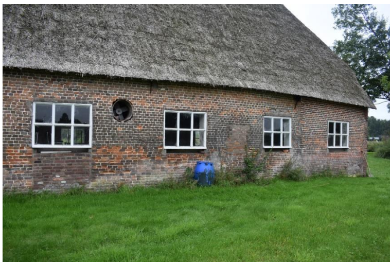
Betonnen zesruits stalvensters.
