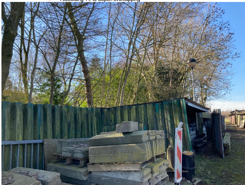
• Afbeelding 14: te slopen overkapping
