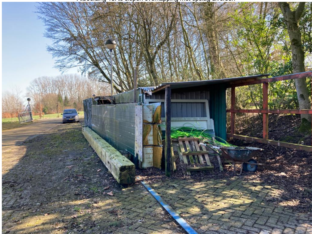
• Afbeelding 13: te slopen overkapping met opslag diversen
