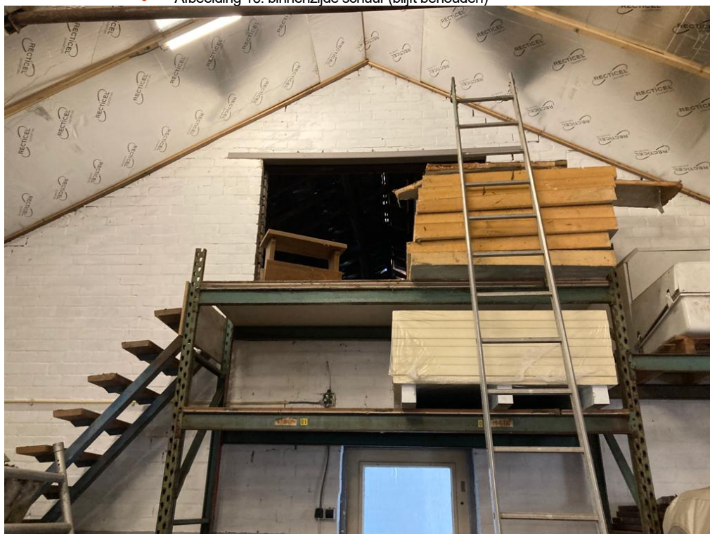
• Afbeelding 16: binnenzijde schuur (blijft behouden)
