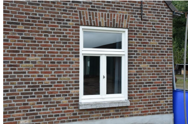
Eén van de vensters onder strek in de linkerzijgevel.
