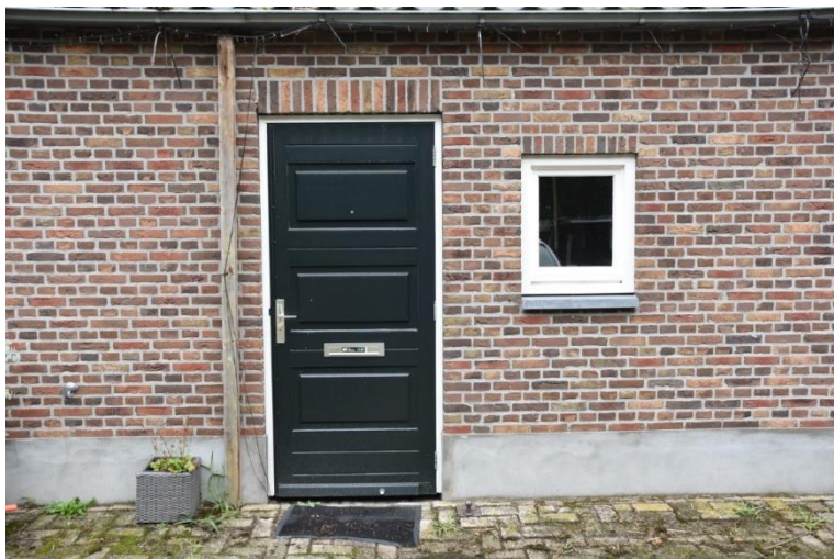
De andere paneeldeur met venster in het oorspronkelijke bedrijfsgeboude.
