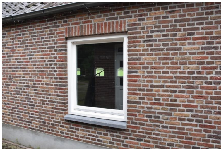
Het meest rechtse venster in de voorgevel.
