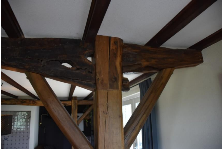
Onder de verbinding is een zaagsnede zichtbaar.
