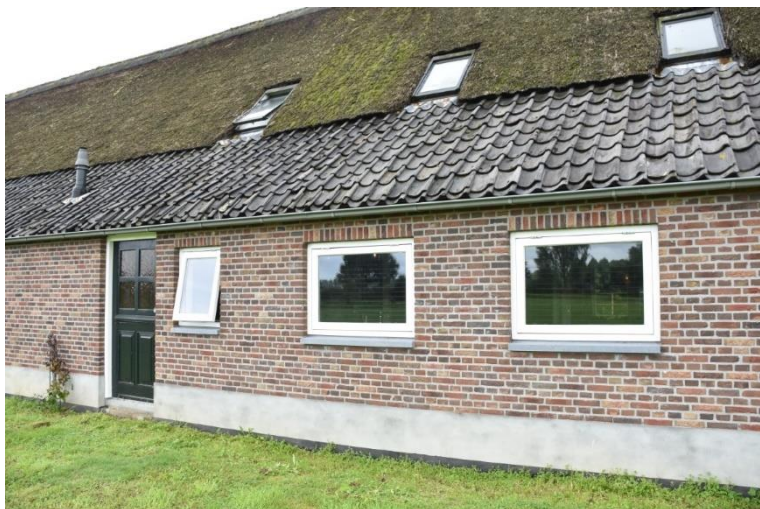
Overgang van oorspronkelijke bedrijfsdeel naar woongedeelte in de achtergevel.
