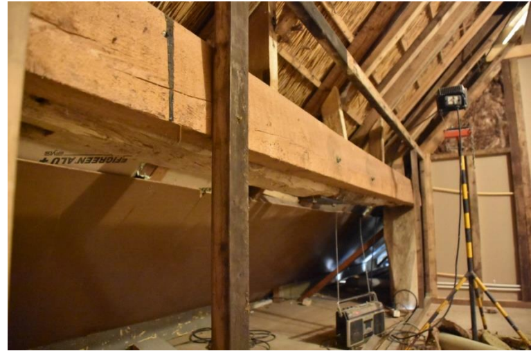
Aan de achtergevelzijde is de worm hier en daar verstevigd met een extra balk.
