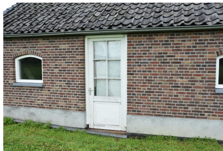
Stalraam en hergebruikte deur in de achtergevel.
