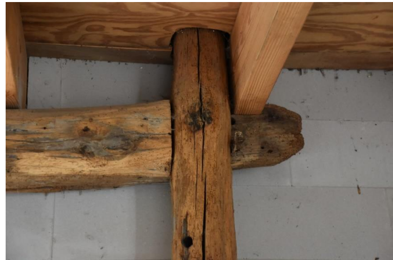
Detail van het ankerbalkgebint.
