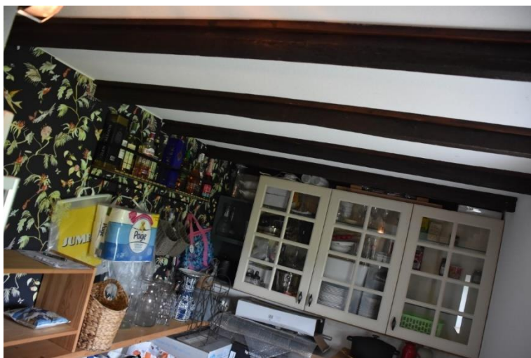
Plafondafwerking in de kelder.
