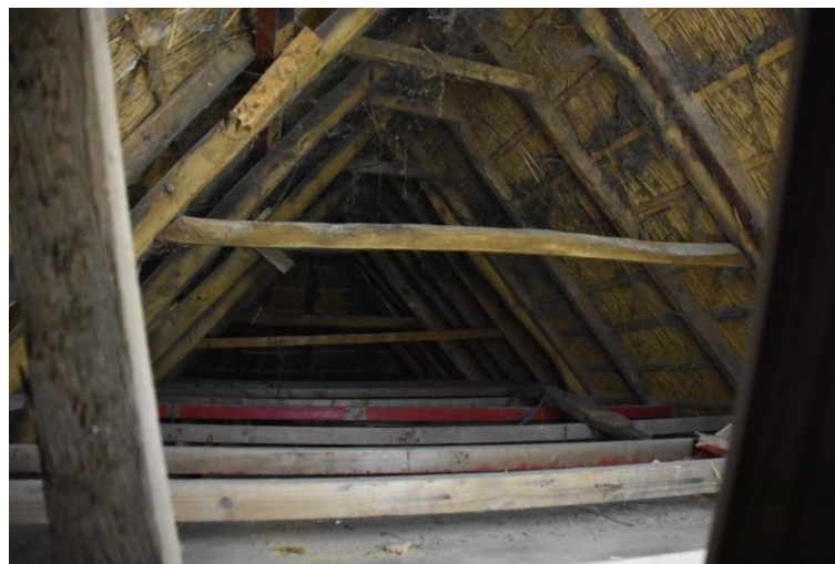
Blik op de kap boven het oorspronkelijk woongedeelte.
