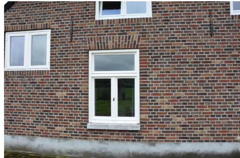
Combinatie opkamervenster en woonkamervenster in de linkerzijgevel.
