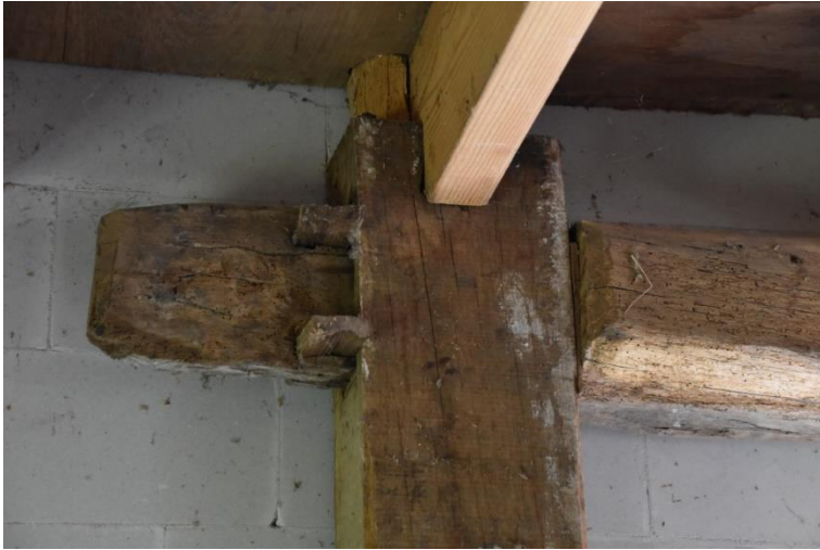
Detail van het ankerbalkgebint.
