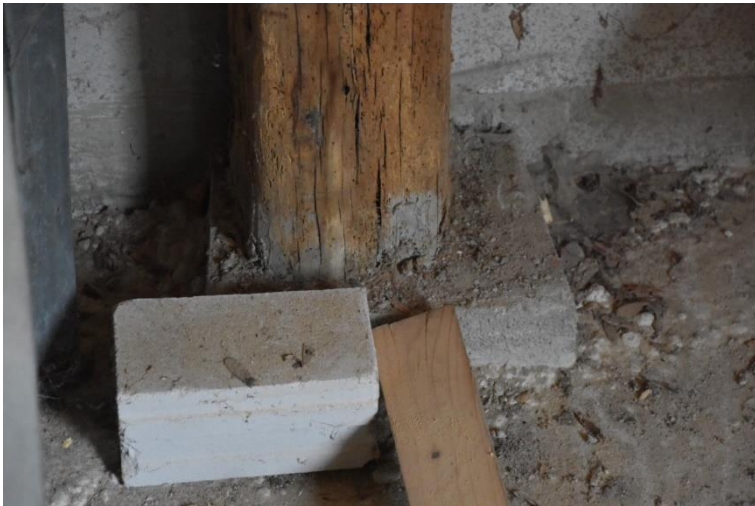
Detail van het gebint met betonnen poer.
