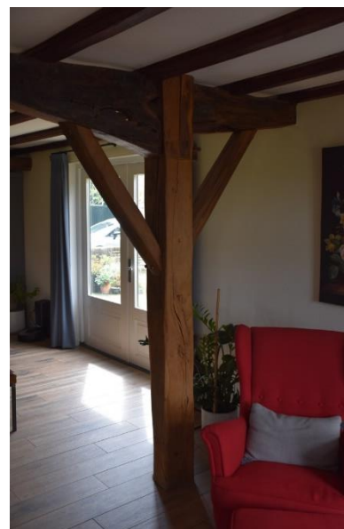
De eerste en tweede gebintstijl in de woonkamer vanaf de linkerzijgevel gezien. De korbelen van beide gebinten zijn hier vernieuwd.
