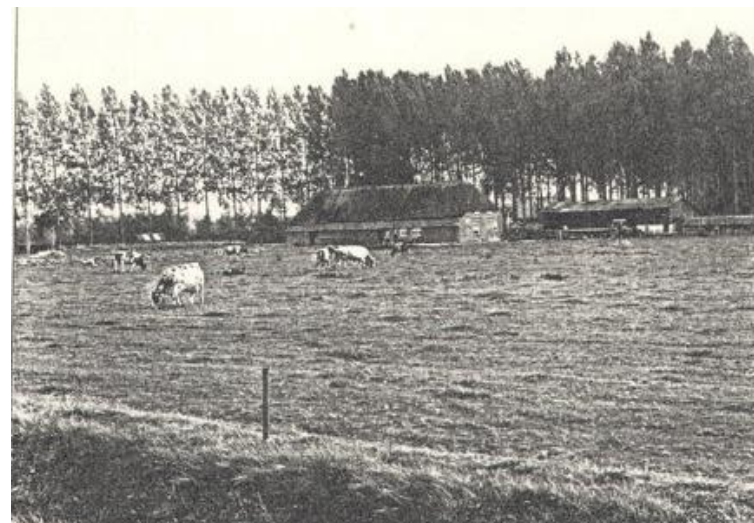
Foto van de langgevelboerderij vanaf de huidige provinciale weg gezien, 1985. Bron: BHIC, archief 1484/10147.
