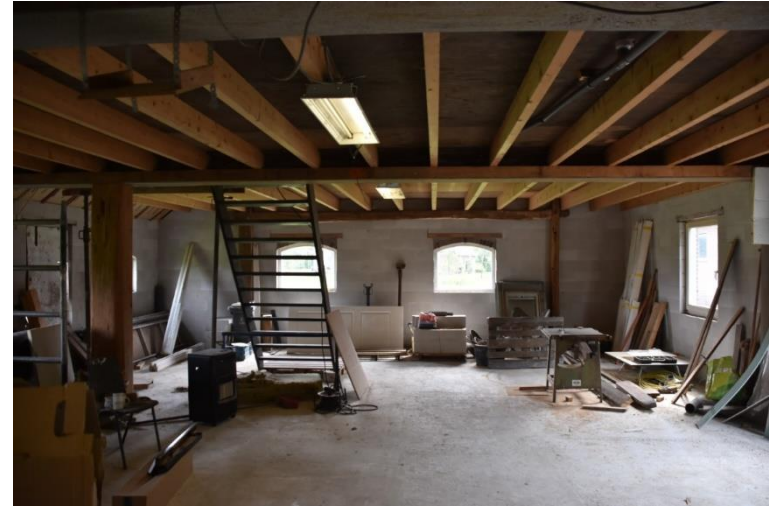
Het vm. bedrijfsgedeelte naar de kopgevel toe gezien.
