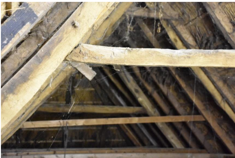
Detail van de kap. Ter ondersteuning van de oorspronkelijke sporen zijn extra sporen aangebracht.
