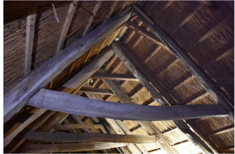
Detail van de sporen met hanenbalk.
