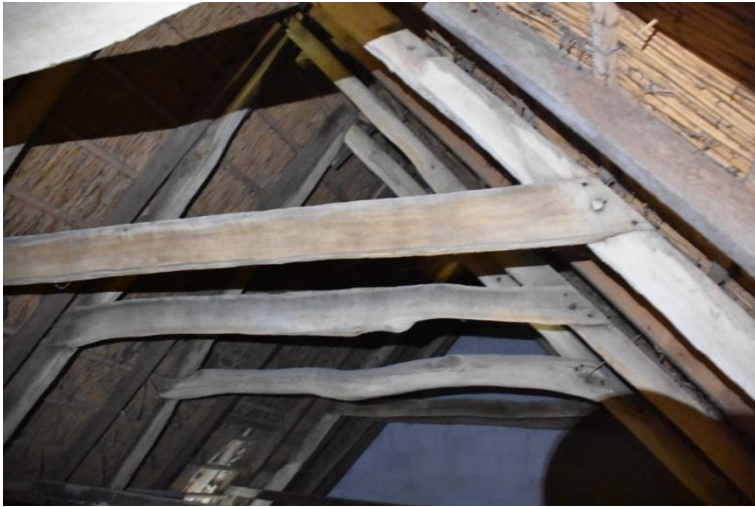
Sporen met hanenbalken. Soms met pen-en-gatverbindingen, soms met nagels of spijkers bevestigd.
