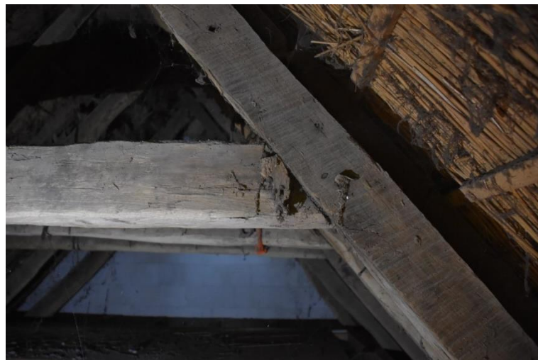
Detail van een van de sporen met pen-en-gatverbinding.
