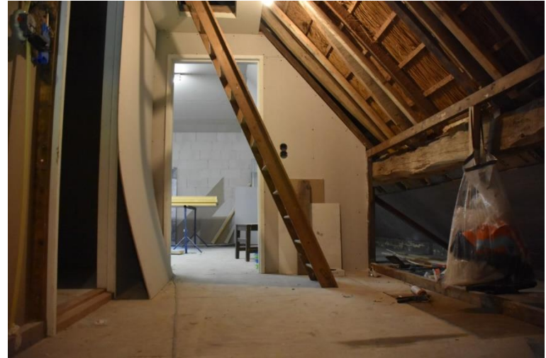
Blik op de half afgewerkte verdieping boven het oorspronkelijke bedrijfsgebied.
