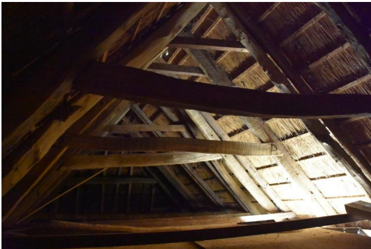
Blik in de sporenkap boven het vm. bedrijfsgedeelte en boven het later aangebrachte plafond.
