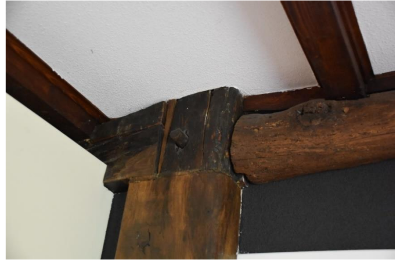
Detail van het gebint in de keuken bij de kelder.
