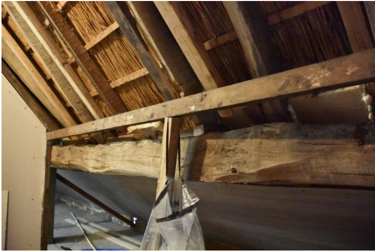
De worm t.h.v. de achtergevel met daarboven zowel oude, als nieuwere daksporen.
