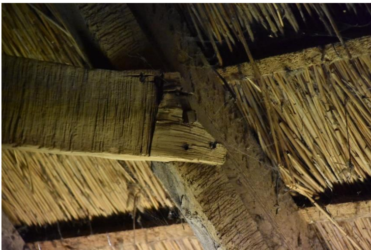
Detail van een van de verbindingen. Ook de zaagsporen op het hout zijn zichtbaar.
