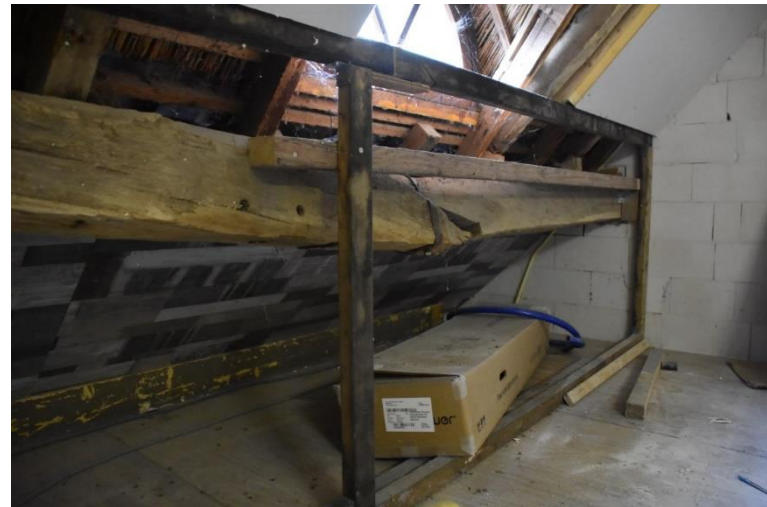
De worm aan de voorgevelzijde zonder extra versteviging.
