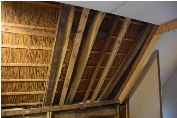
Ook hier liggen oude en nieuwere daksporen naast elkaar.
