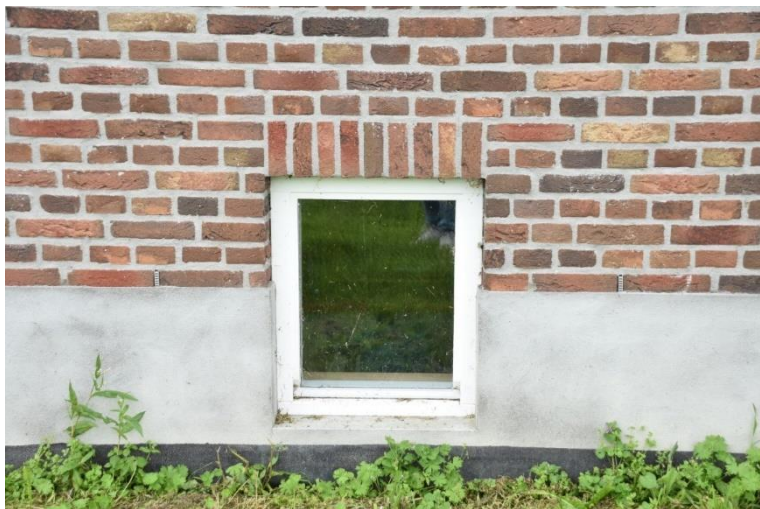
Het kelderlicht rechts in de achtergevel.
