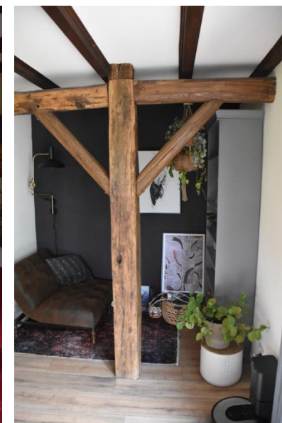
De eerste en tweede gebintstijl in de woonkamer vanaf de linkerzijgevel gezien. De korbelen van beide gebinten zijn hier vernieuwd.
