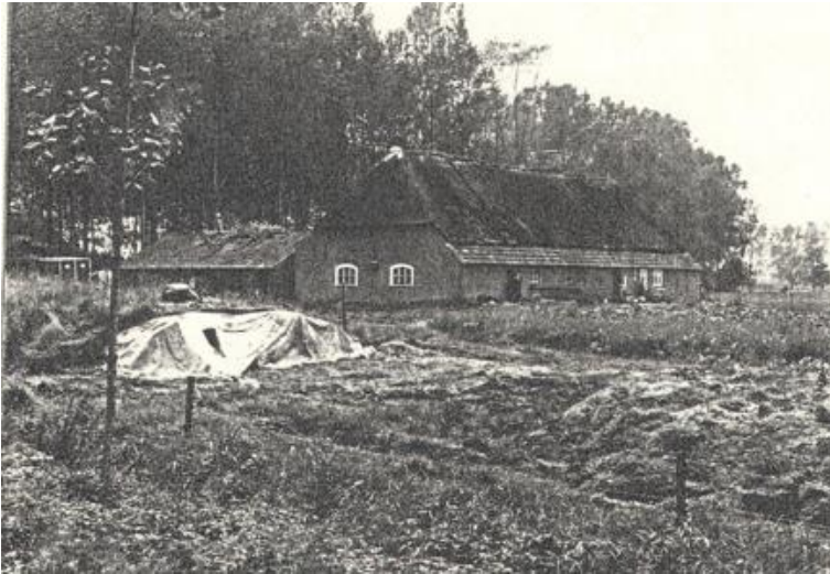
Foto van de langgevelboerderij vanaf de Olieëindsestraat gezien, 1985. Links de aanbouw tegen de boerderij. Bron: BHIC, archief 1484/10147.
