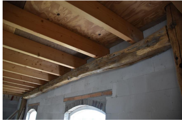
Detail van het oudere ankerbalkgebint tegen de kopgevel.
