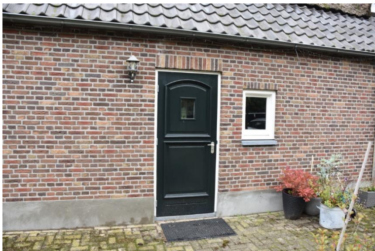
De huidige voordeur en venster behorend bij het huidige woongedeelte, in het oorspronkelijke bedrijfsgeboude.
