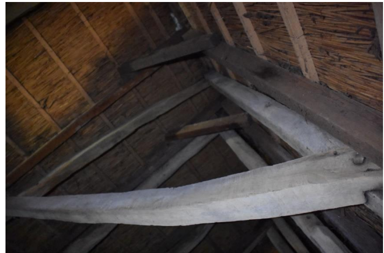
Naast sommige oude sporen zijn later extra sporen aangebracht.
