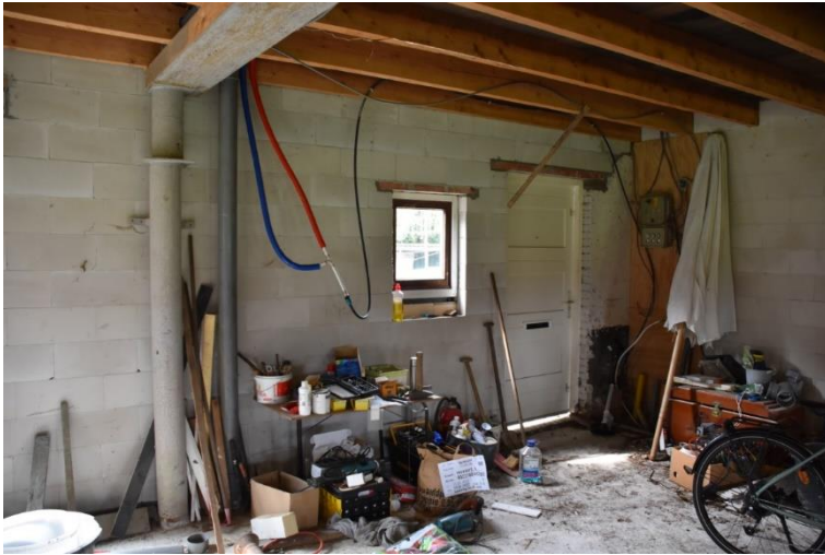
Naar de voorgevel toe gezien met de toegangsdeur en één van de stalen kolommen.
