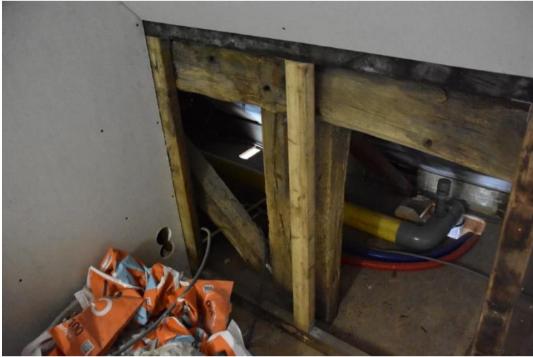
Nog een doorstekende gebintstijl van het ankerbalkgebint met daarop de worm. Ook een van de schoren is hier nog aanwezig.
