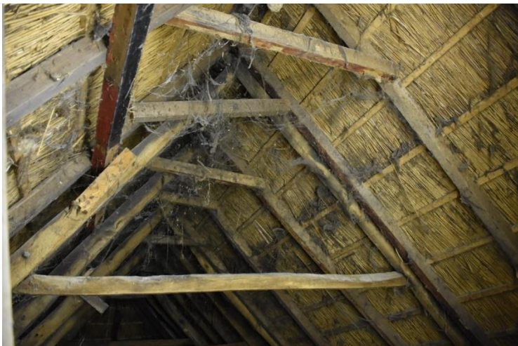
Een klein gedeelte van de kap waar veel oude sporen zijn vervangen.
