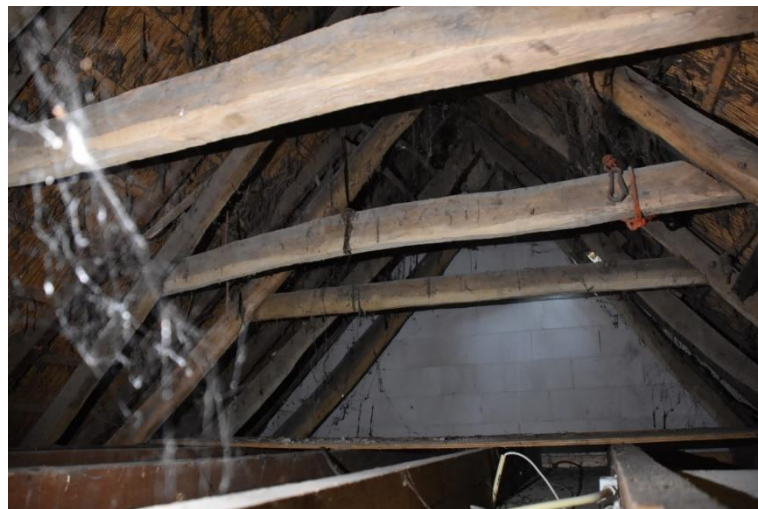
Een nog authentiek deel van de kapconstructie.
