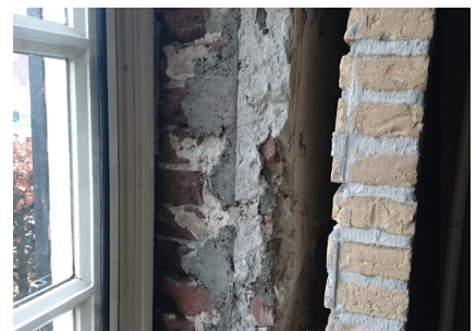
oude buitenmuur is ingemetseld tussen een nieuwe buiten- en binnenmuur
