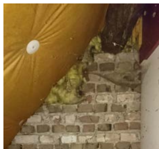
oude buitenmuur zichtbaar op zolder
