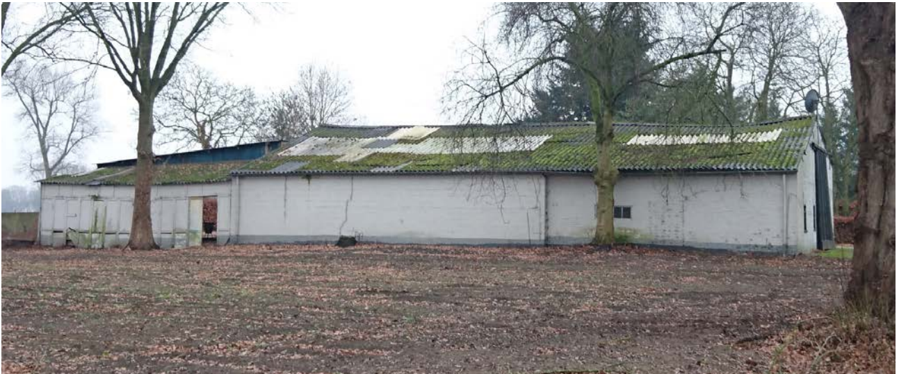
linkerzijgevel schuur Schootsestraat 50
