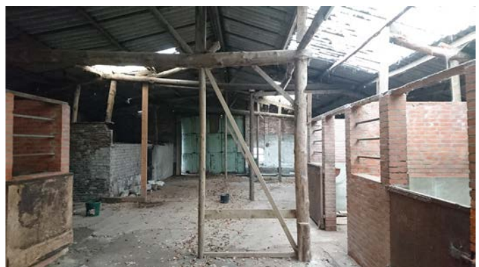
interieur schuur Schootsestraat 50
