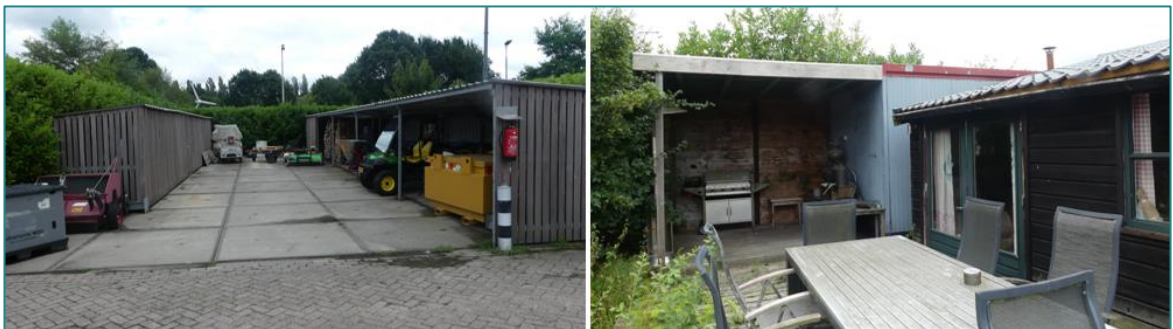
Figuur 1 Het plangebied is gelegen te Vossenbergsesteeg 5 te Schijndel. De te slopen bebouwing betreft 2 overkappingen (links), een hobbyhok en buitenhuis (rechts).
