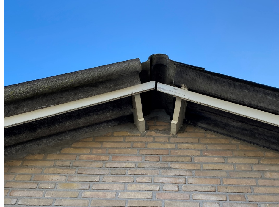
Figuur 20. Alle kieren in gevels zijn dichtgemetseld.
