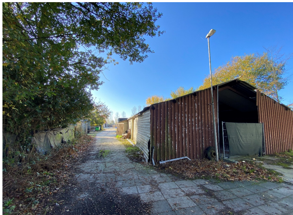
Figuur 24. Beeld van de open loods in het uiterste noordwesten van het terrein.
