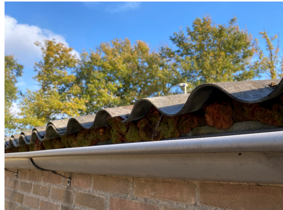
Figuur 21. De asbest golfplaten zijn allemaal volledig dichtgepurd.
