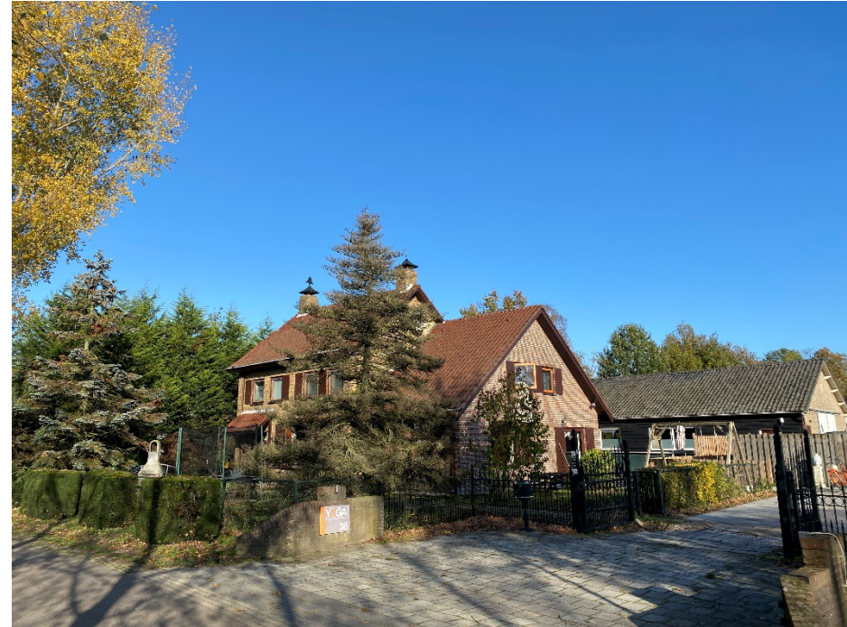
Figuur 26. Beeld van de woning in het zuidwesten van het terrein.
