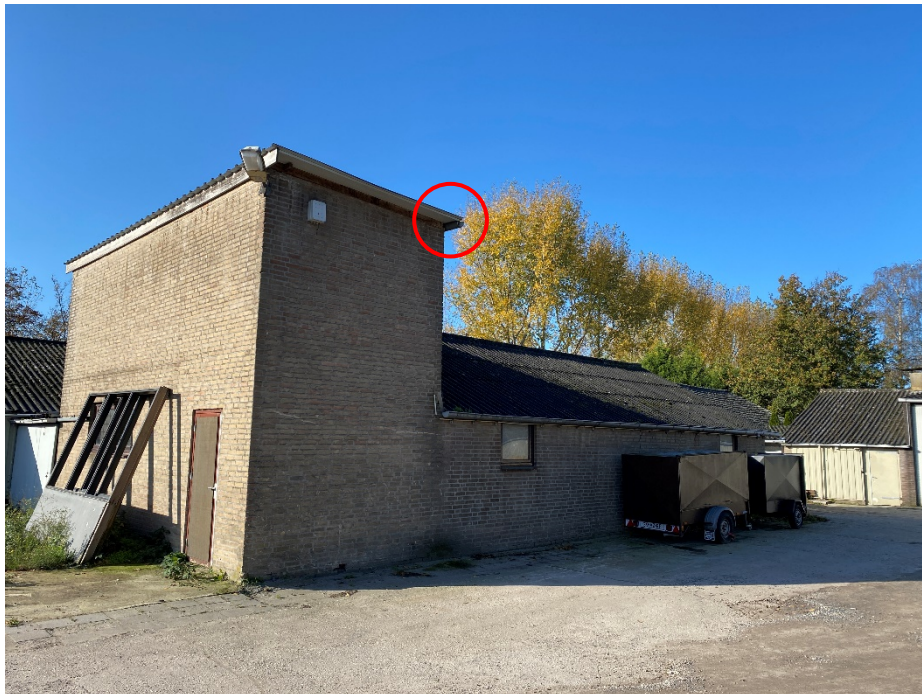
Figuur 19. In het gebouw op de foto is een opening aanwezig (rode cirkel) die geschikt is voor gierzwaluw om te broeden.
