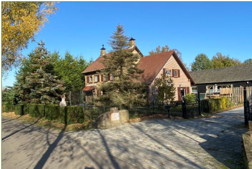
Foto 1: het woonhuis. De oprit wordt verplaatst richting het oosten.
