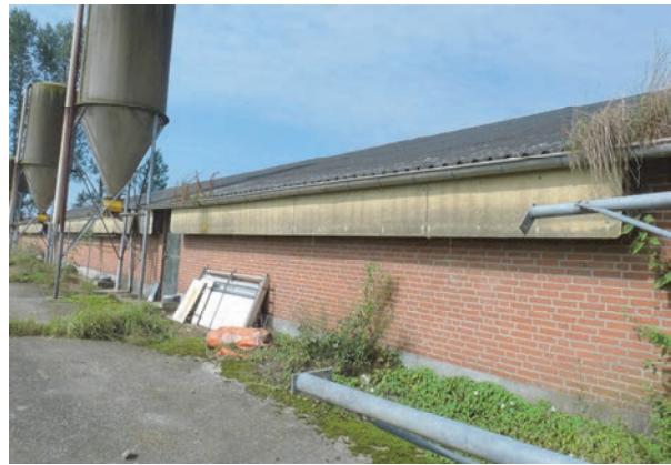
Fig. 6. Oostzijde van de schuur, met de silo's en met een betonnen pad er naast. Foto genomen richting het zuiden.
