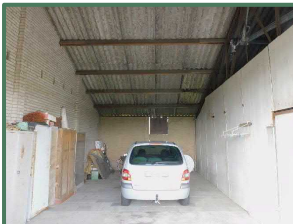
Binnenzijde te behouden schuur
