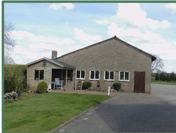
Overzicht kopgevel te behouden deel schuur
