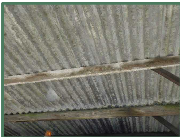
Onderkant dak schuur
