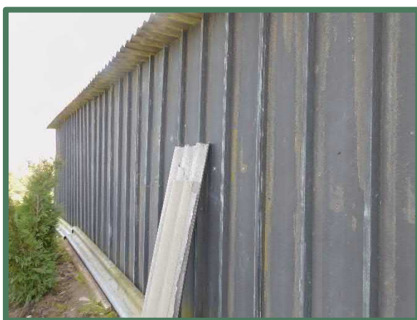
Achterzijde te slopen deel van de schuur
