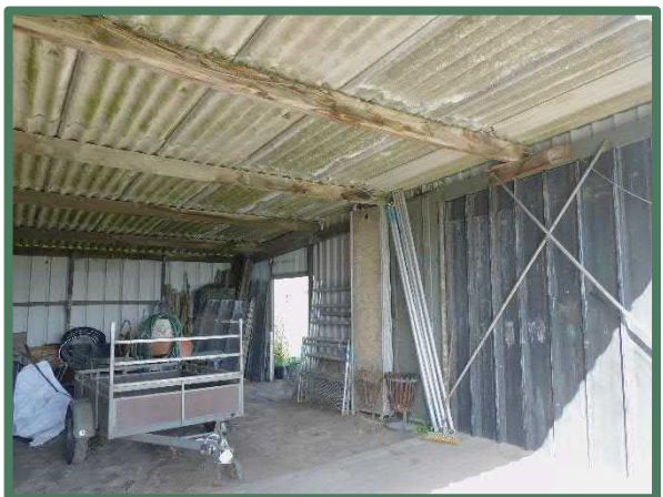
Overzicht binnen in te slopen schuur
