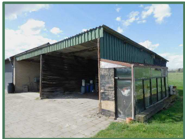
Overzicht te slopen deel van de schuur
