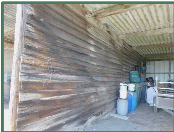
Te behouden achterwand van schuur
