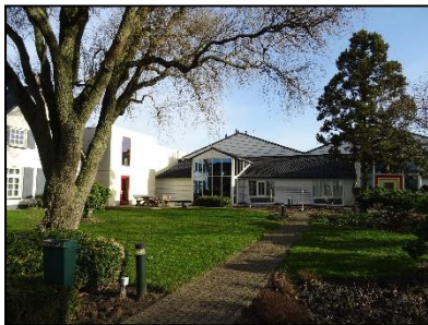
Figuur 3. Vooraanzicht bedrijfsgebouw.
