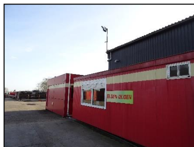
Figuur 7. Kantoorunits aan de noordzijde van het bedrijfsgebouw.
