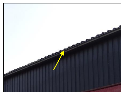
Figuur 18. Ruimte onder golfplaten geschikt als broedplaats huismus.
