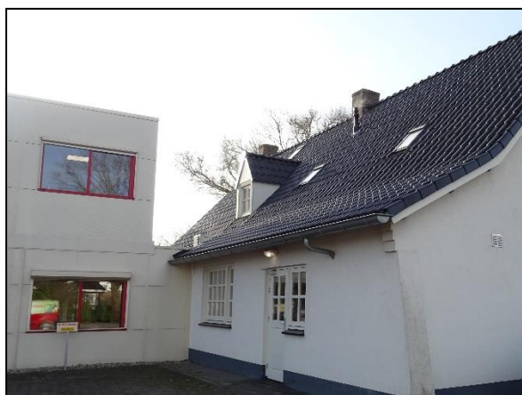
Figuur 21. Ruimte onder overhangende dakpannen en in eventueel aanwezige spouwmuur geschikt voor vleermuizen.
