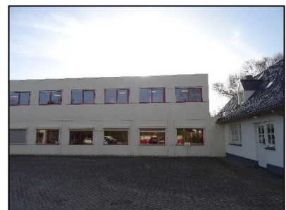
Figuur 8. Kantoorunits aan de westzijde van het bedrijfsgebouw.
