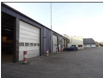
Figuur 6. Noordwestzijde bedrijfsgebouw.
