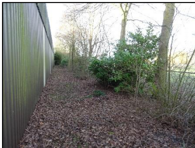
Figuur 12. Groenstrook aan de westzij-de van de loods.
