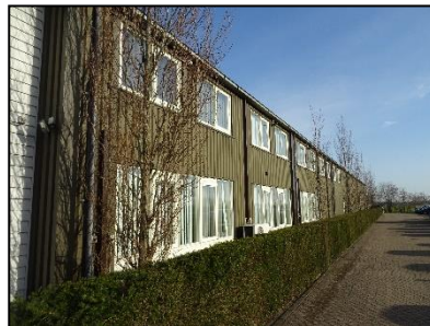
Figuur 4. Zuidzijde bedrijfsgebouw.
