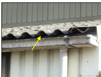
Figuur 17. Ruimte onder golfplaten geschikt als broedplaats huismus.
