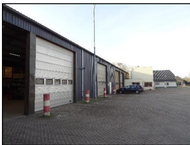
Figuur 6. Noordwestzijde bedrijfsgebouw.
